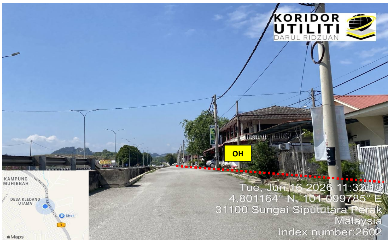
LOKASI DI KAMPUNG BARU RIMBA PANJANG
