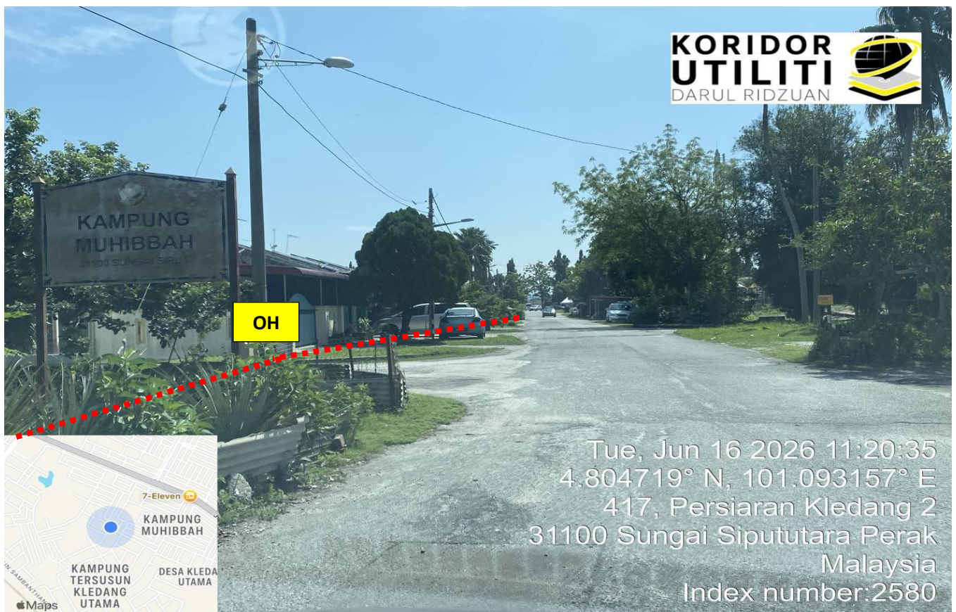
LOKASI DI KAMPUNG MUHIBBAH
