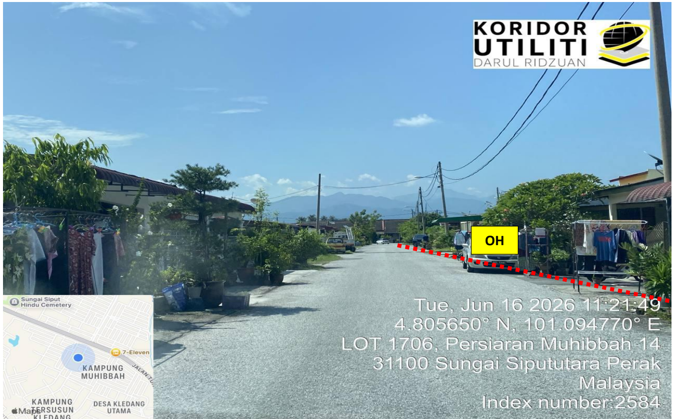
LOKASI DI KAMPUNG MUHIBBAH
