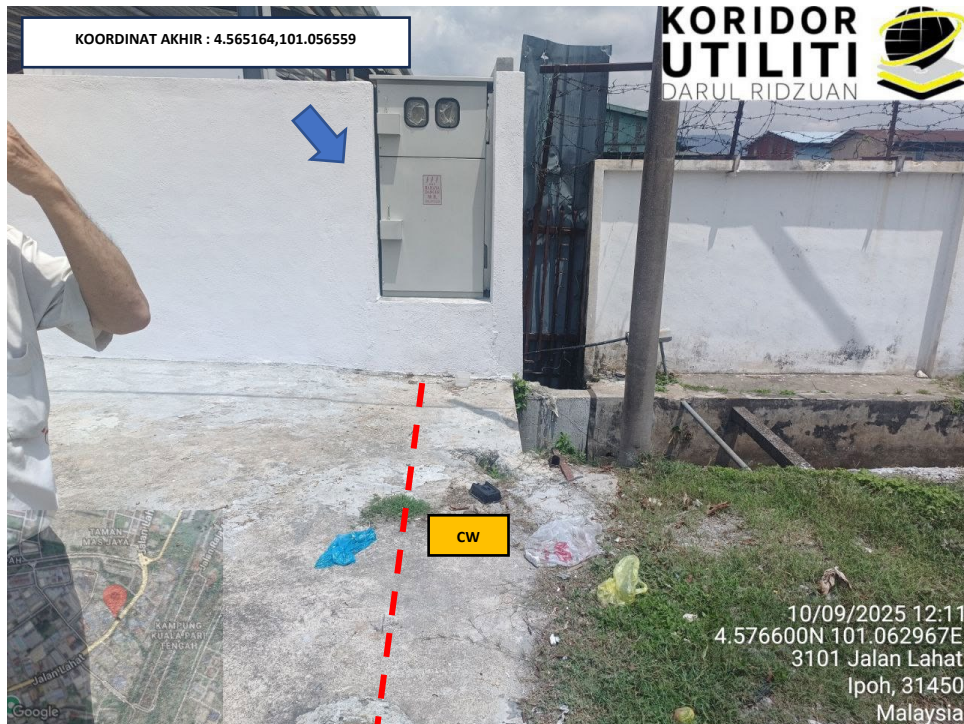
LOKASI KOORDINAT AKHIR KOREKAN TERBUKA DI JALAN LAHAT
