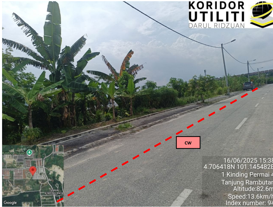
JAJARAN KOREKAN TERBUKA DI JALAN KINDING RAYA 5
