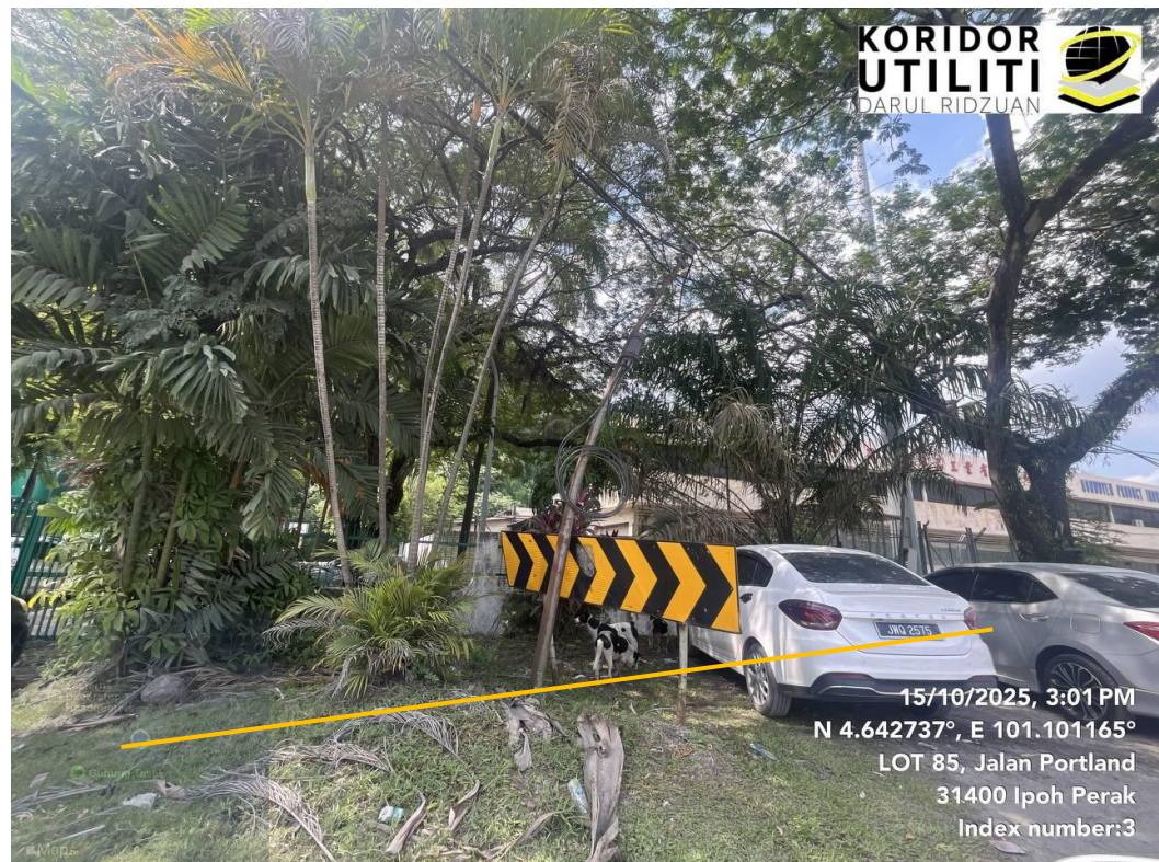
KOREKAN TERBUKA DI BAHU JALAN 52 METER
