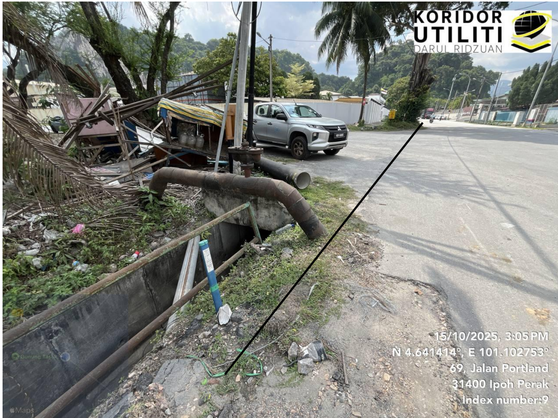
CABLE PULLING DARI MANHOLE SEDIA ADA MAXIS
