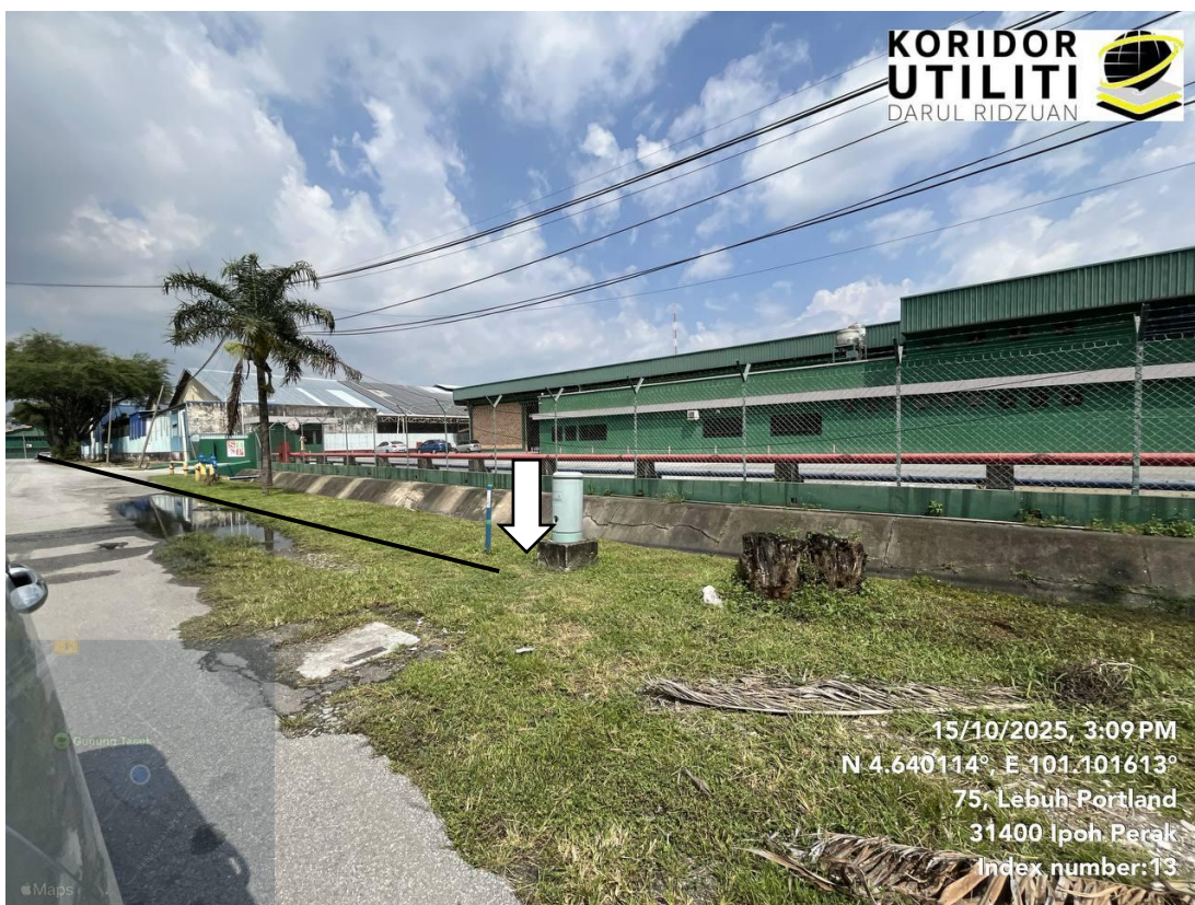
KERJA CABLE PULLING 371 METER
