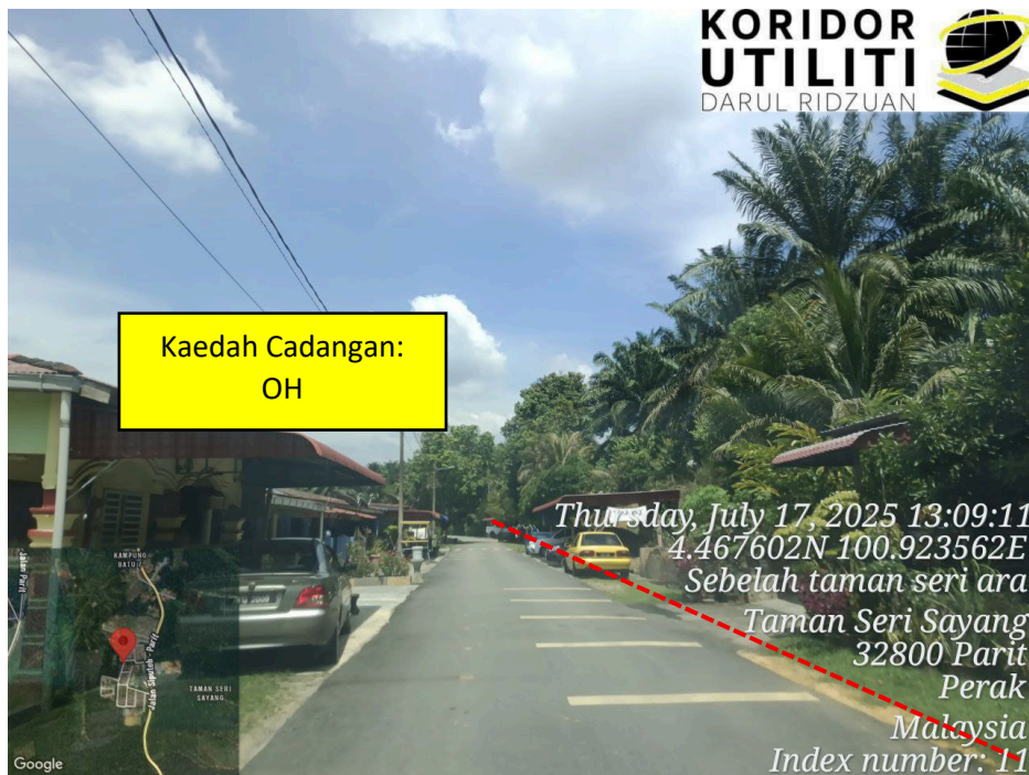
LOKASI: Taman Seri Sayang – Kaedah Penanaman Tiang
