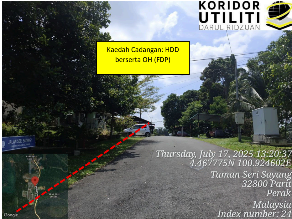
LOKASI: Jalan Seri Sayang 1 – Kaedah Penanaman Tiang
