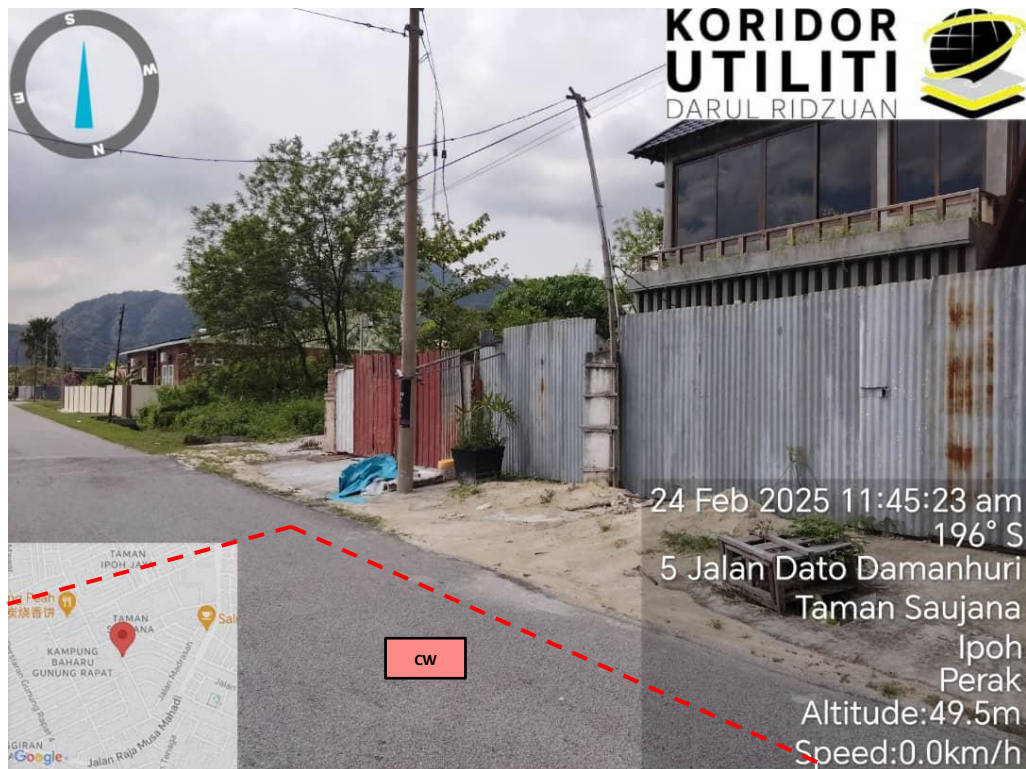
JAJARAN KOREKAN TERBUKA DI JALAN DATO DAMANHURI
