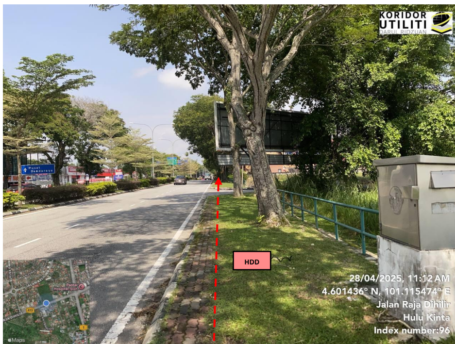
JAJARAN KERJA HDD DI JALAN RAJA DIHILIR
