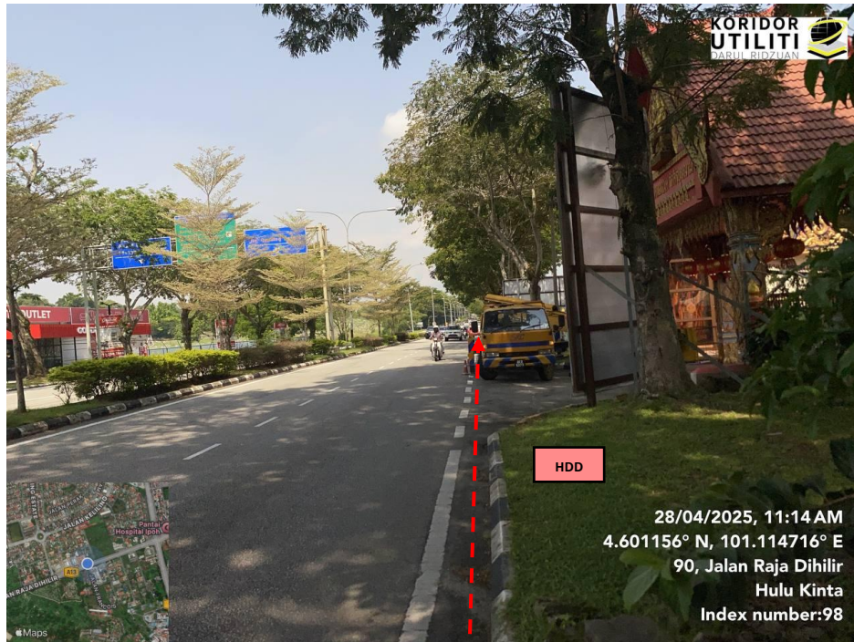
JAJARAN KERJA HDD DI JALAN RAJA DIHILIR
