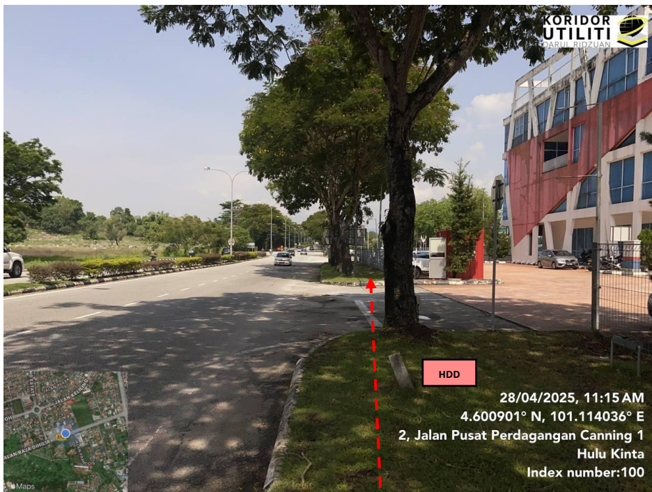
JAJARAN KERJA HDD DI JALAN RAJA DIHILIR
