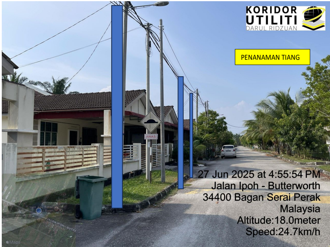
LOKASI DI JALAN TAMAN SERAI BAIDURI
