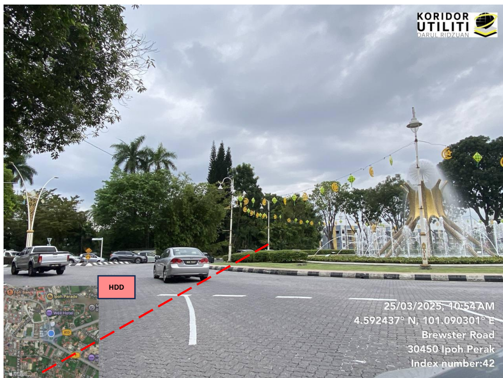
JAJARAN HDD DI JALAN SULTAN IDRIS SHAH – BULATAN SULTAN ABDUL AZIZ (Sambungan akan dibuat daripada PPU Hospital Bainun ke IPO 5448)
