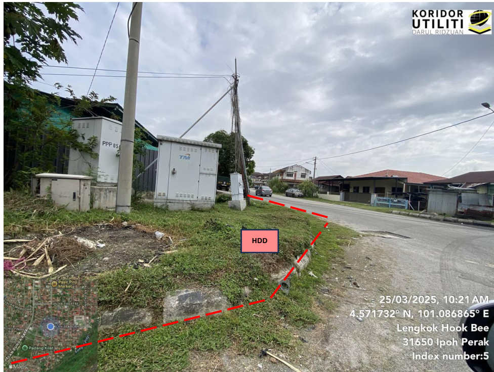
JAJARAN HDD DI JALAN BUNGA ANGERIK (Sambungan akan dibuat daripada PPU Pinji Lane)
