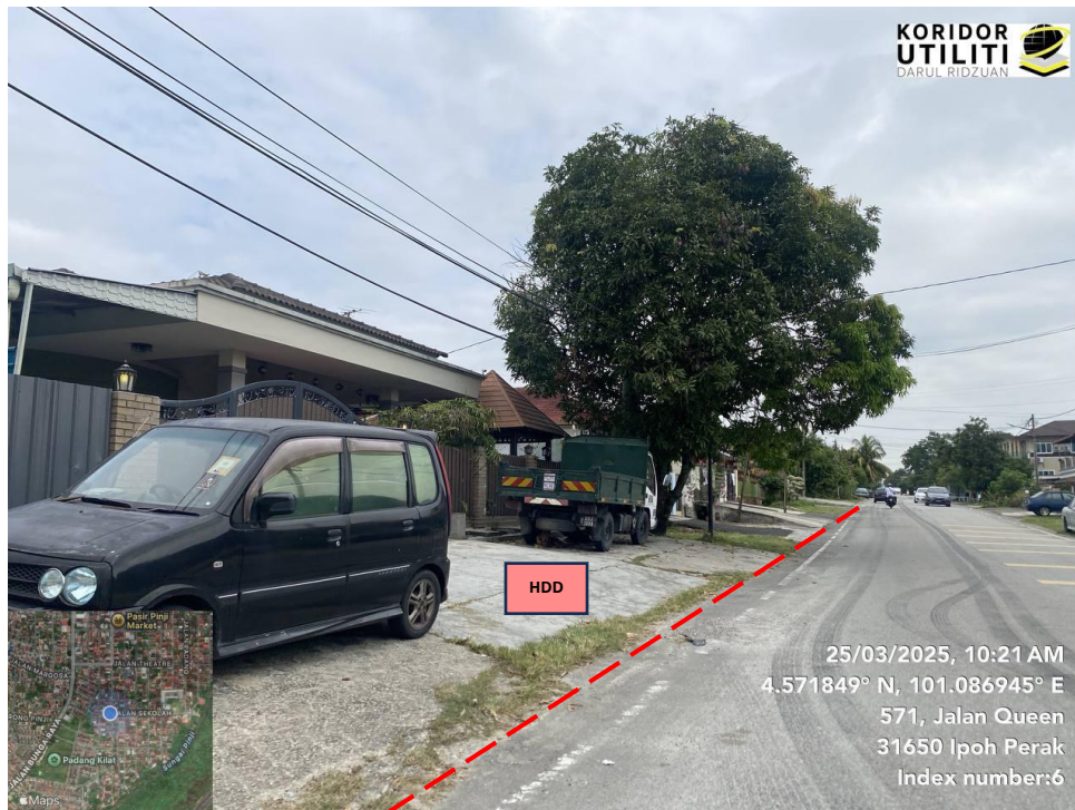
JAJARAN HDD DI JALAN QUEEN (Sambungan akan dibuat daripada PPU Pinji Lane)
