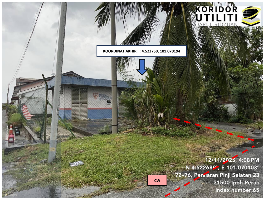
LOKASI KOORDINAT AKHIR KOREKAN TERBUKA DI PERSIARAN PINJI SELATAN 23
