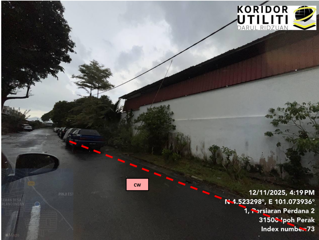
JAJARAN KOREKAN TERBUKA DI PERSIARAN PERDANA 2
