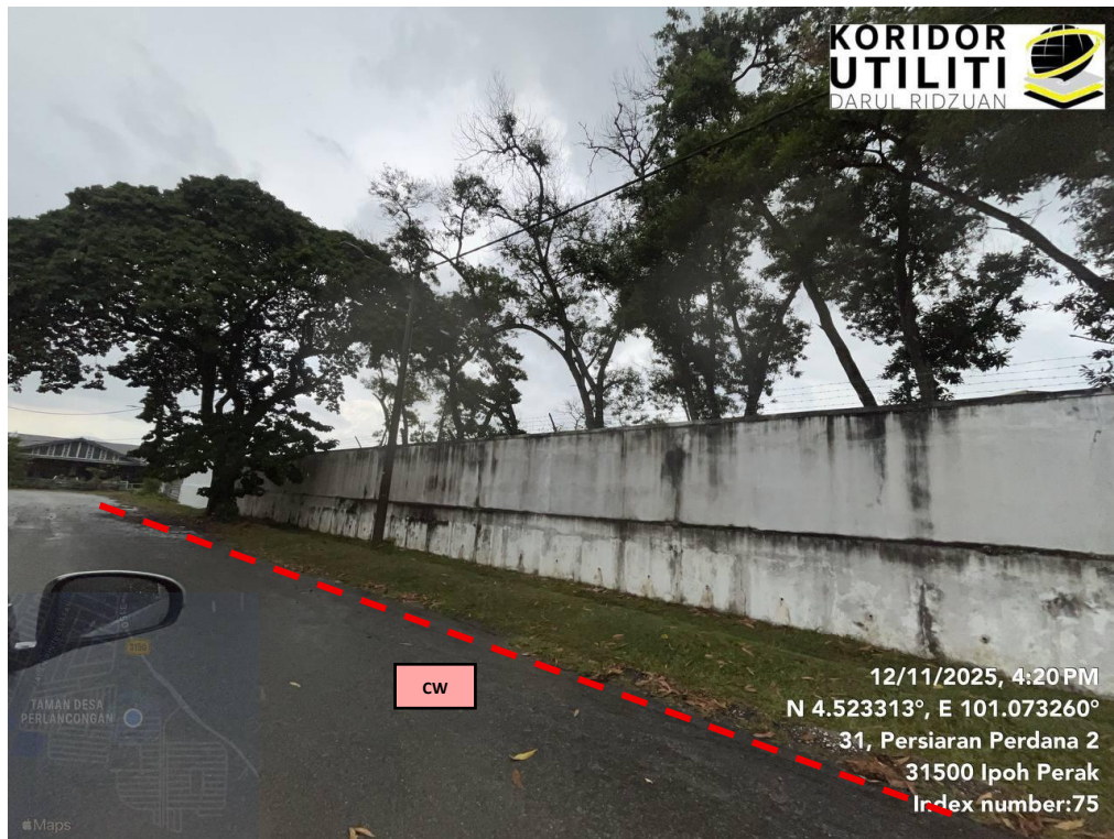
JAJARAN KOREKAN TERBUKA DI PERSIARAN PERDANA 2
