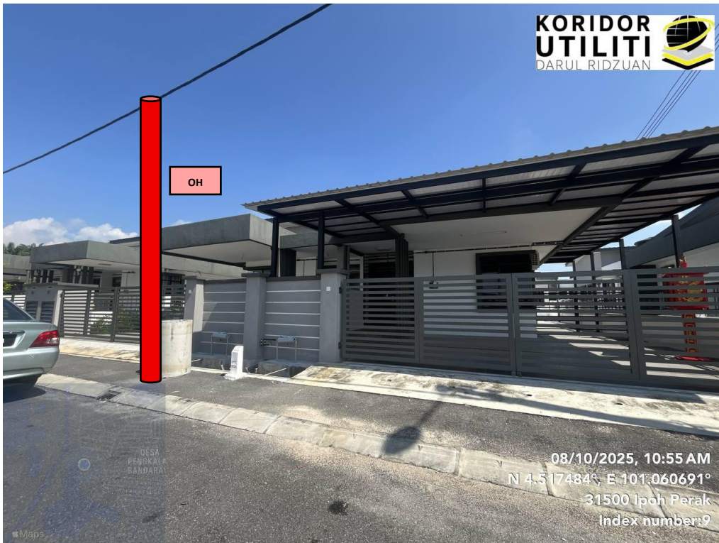
JAJARAN KERJA PENANAMAN TIANG DAN PENARIKAN KABEL DI PENKALAN PERMAI 32
