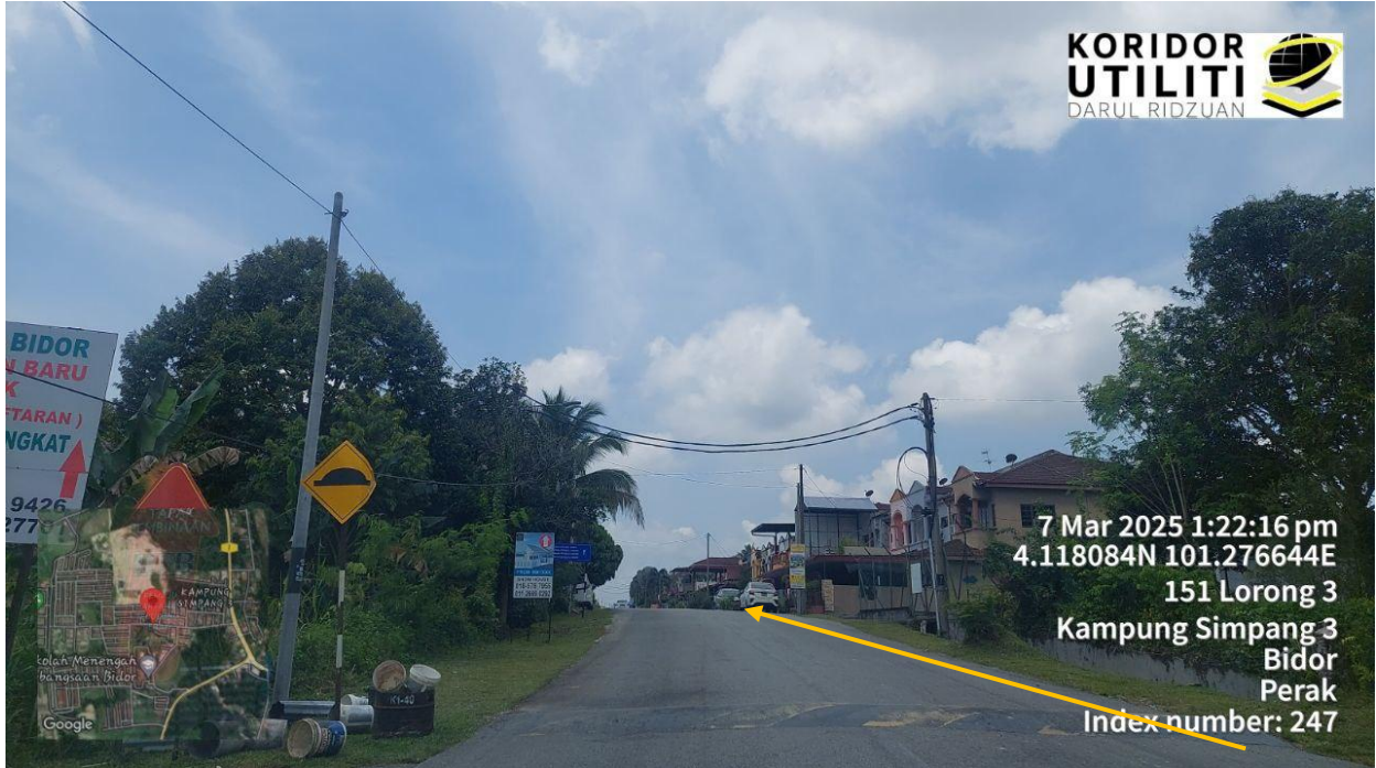
KERJA KOREKAN DI JAJARAN SEBELAH KANAN
