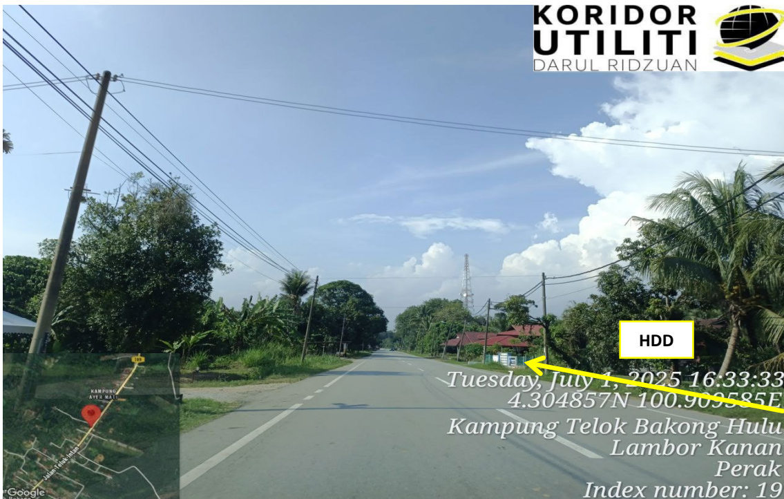
JALAN BOTA KANAN – KG GAJAH – TELUK INTAN (109)
