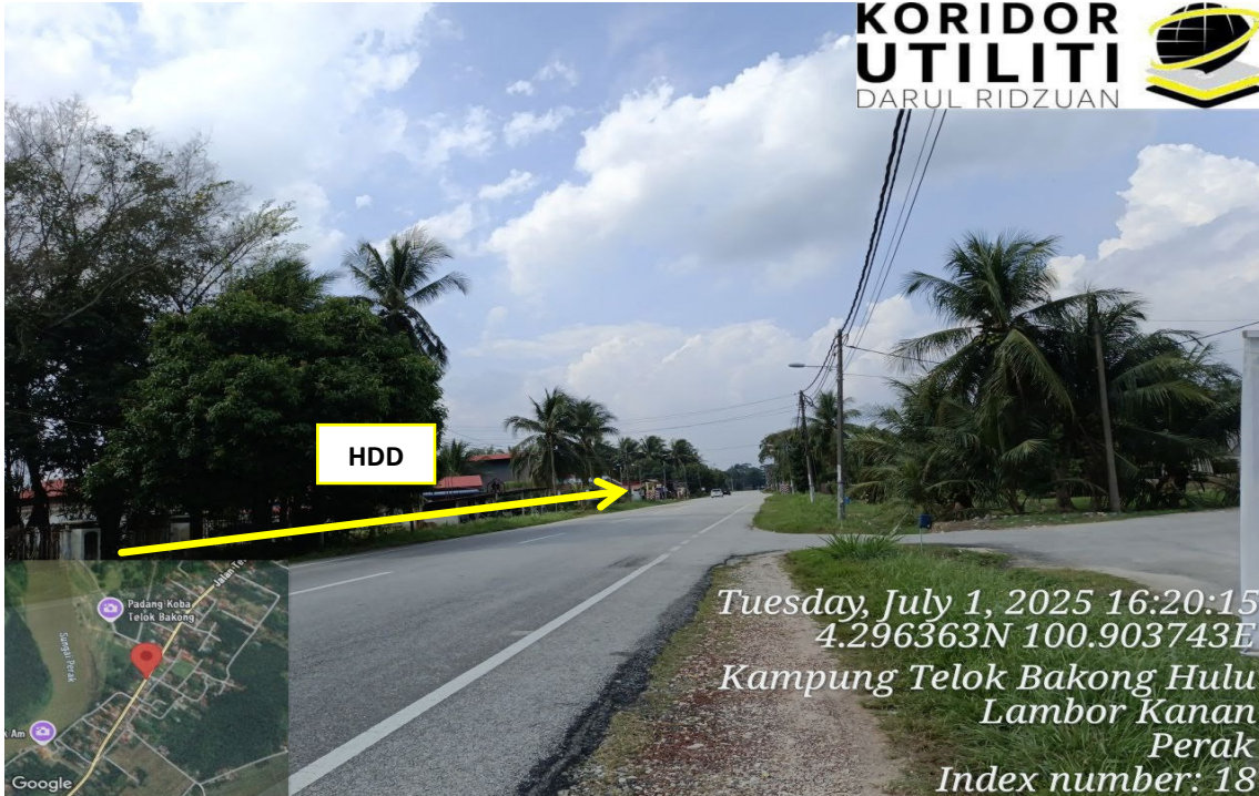
JALAN BOTA KANAN – KG GAJAH – TELUK INTAN (109)
