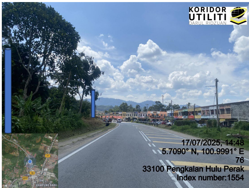
LOKASI DI JALAN ISKANDAR
