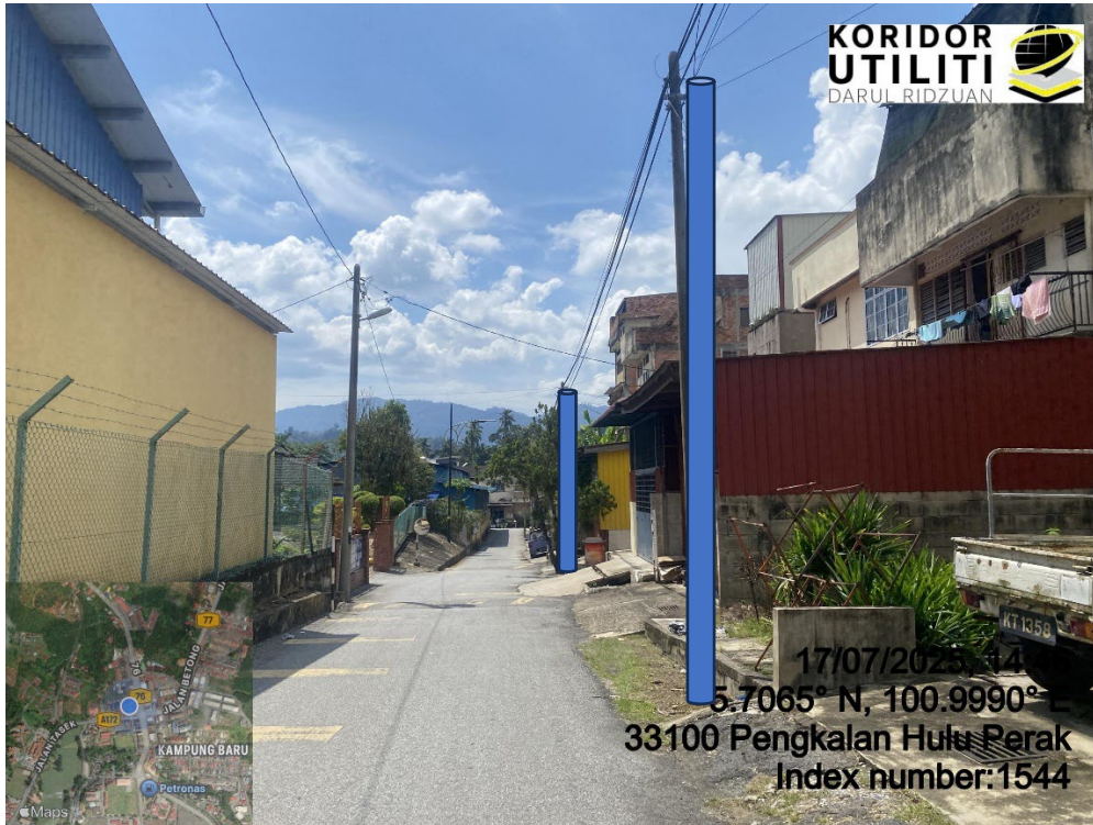
LOKASI DI JALAN PENGKALAN HULU
