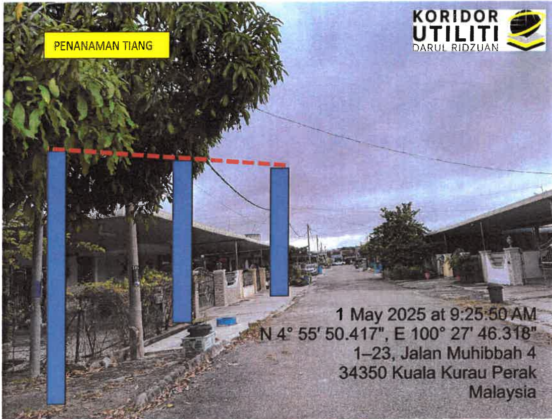
LOKASI DI JALAN TAMAN MUHIBAH
