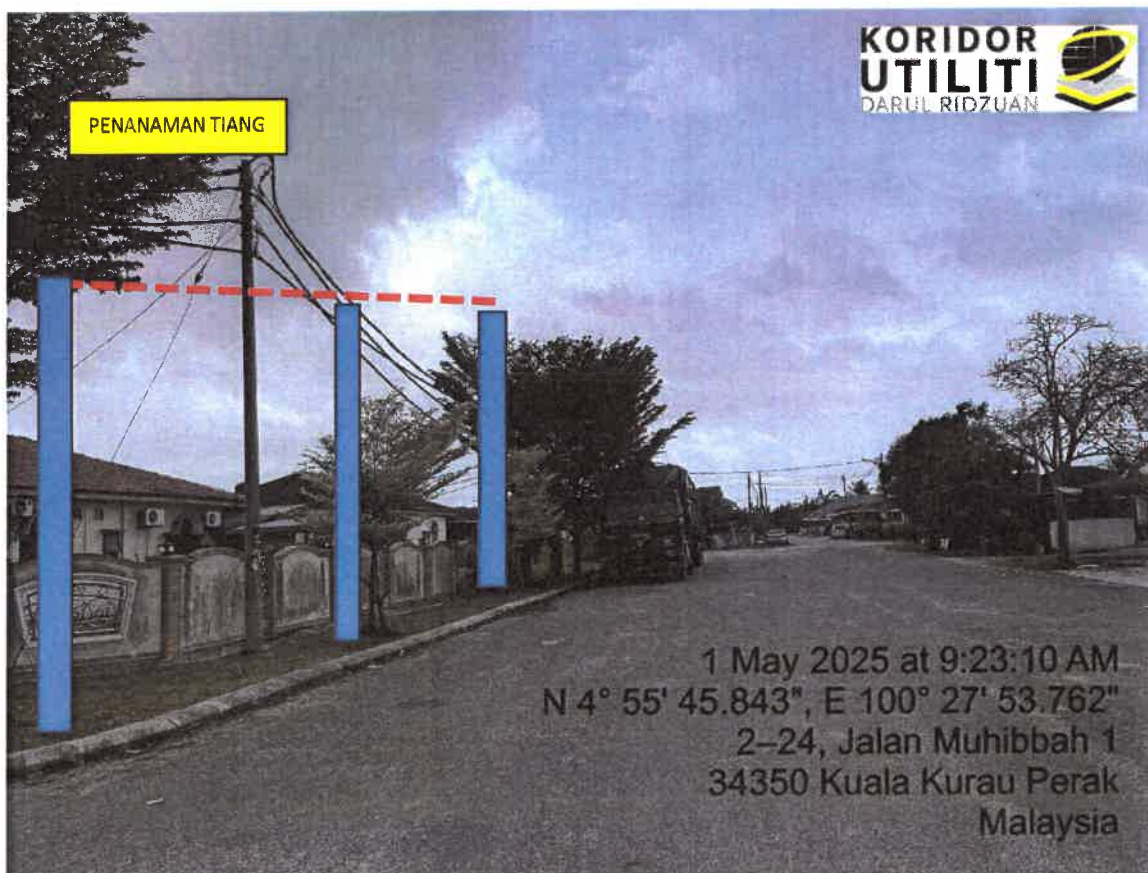
LOKASI DI JALAN TAMAN MUHIBAH
