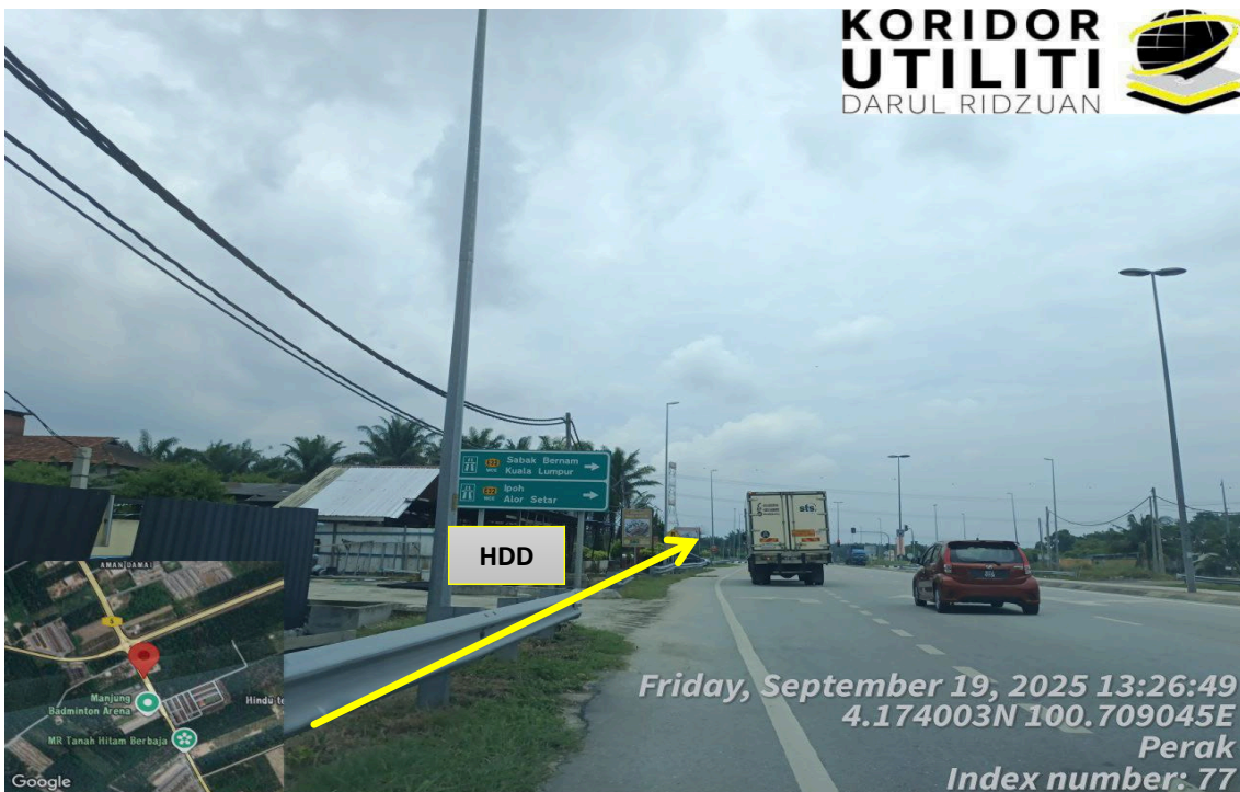
LOKASI KERJA DI JALAN SG WANGI – KG KAYAN (5) (MANJUNG)
