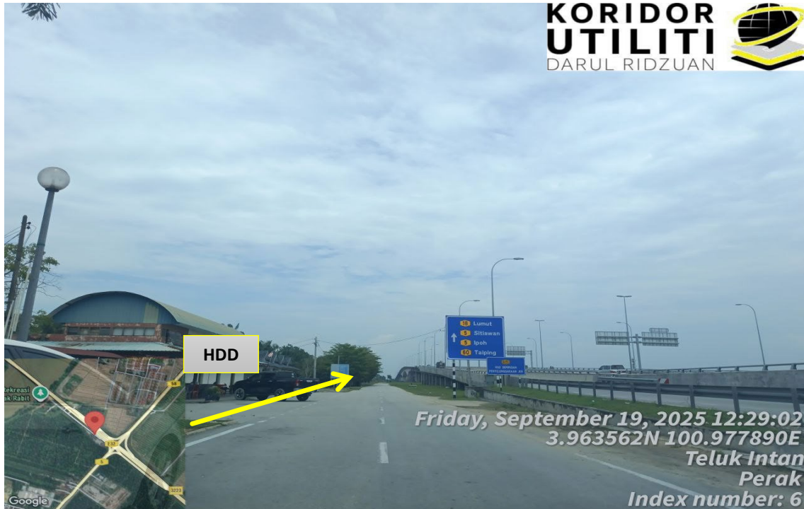
LOKASI KERJA DI PLAZA RNR BATU 5 (MAJLIS PERBANDARAN TELUK INTAN)
