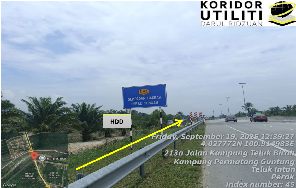
LOKASI KERJA DI JALAN TELUK INTAN – KG LEKIR (5)
