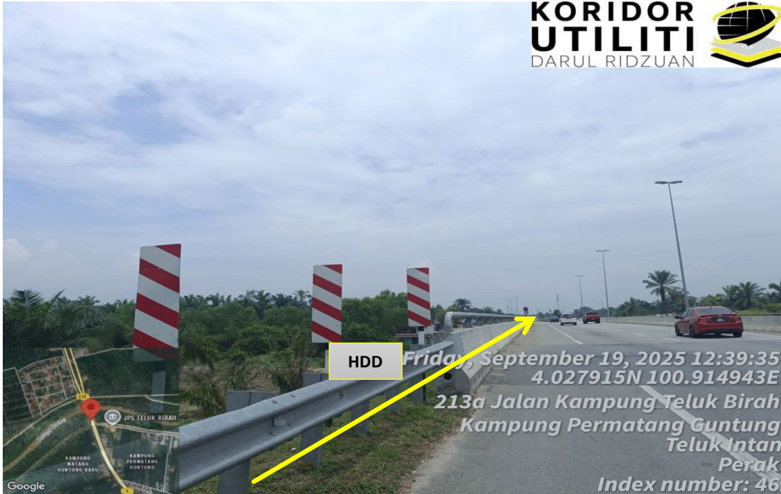
LOKASI KERJA DI SUNGAI DEDAP (JPS PERAK TENGAH)
