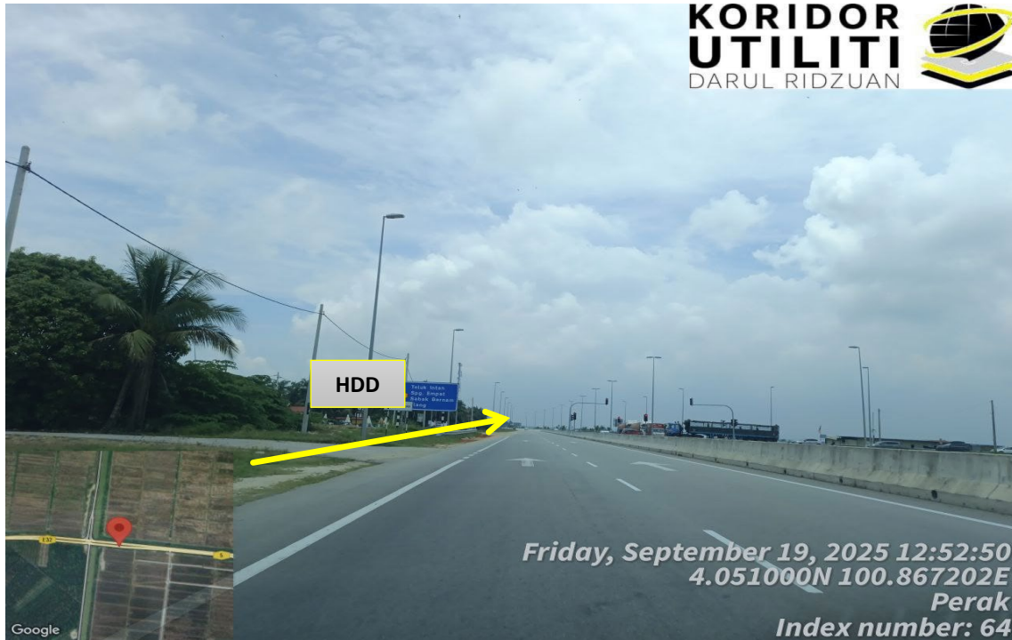
LOKASI KERJA DI JALAN TELUK INTAN – KG LEKIR (5) (PERAK TENGAH)
