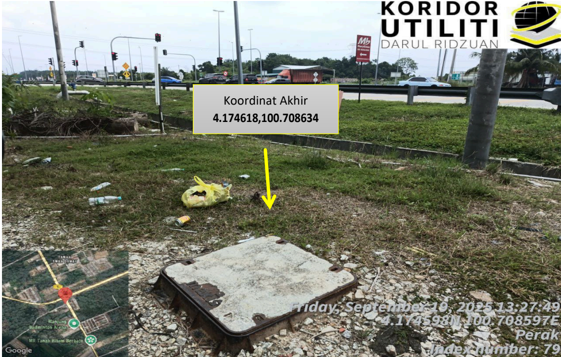
LOKASI KERJA DI JALAN SG WANGI – KG KAYAN (5) (MANJUNG) (KOORDINAT AKHIR)
