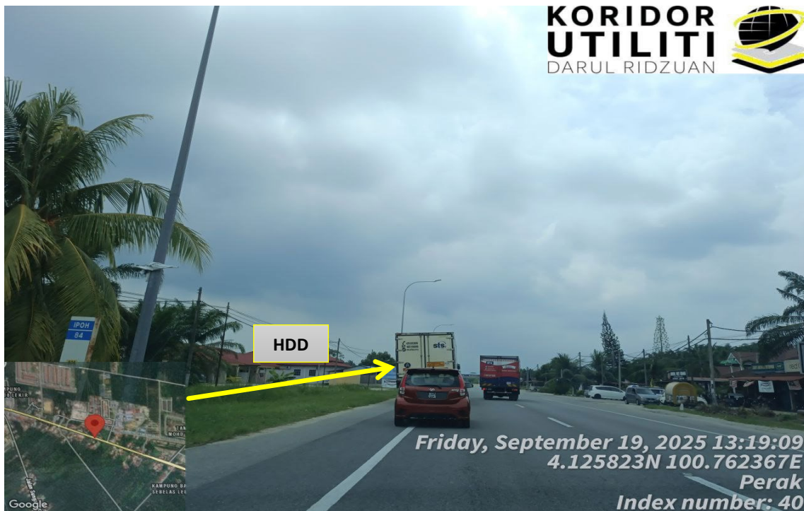
LOKASI KERJA DI JALAN SUNGAI WANGI – KG KAYAN (5) (MANJUNG)
