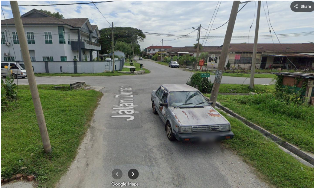
AJARAN KERJA HDD MASUK KE JALAN MILIK MBI (JALAN DURIAN)
