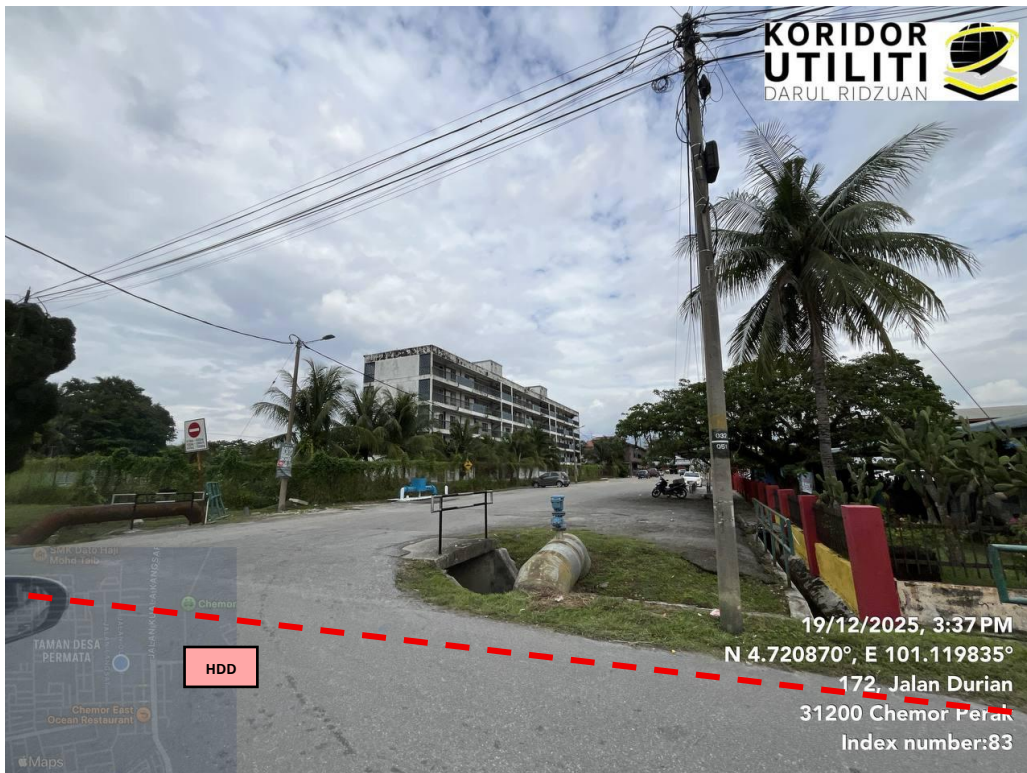
AJARAN KERJA HDD MASUK KE JALAN MILIK MBI (JALAN DURIAN)
