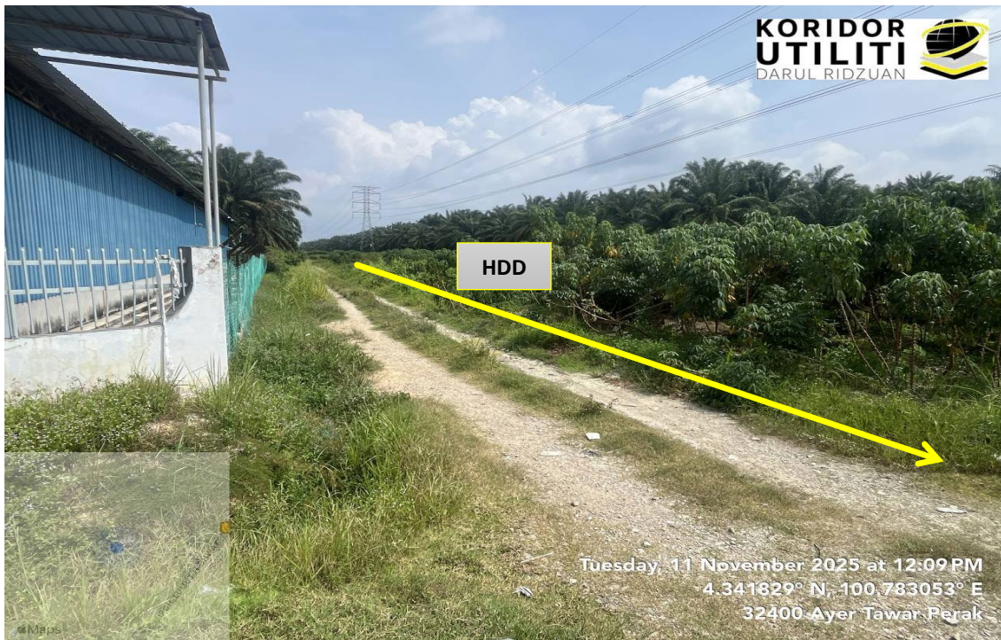
AJARAN KERJA HDD DI JALAN RENTIS TNB (PDT MANJUNG)
