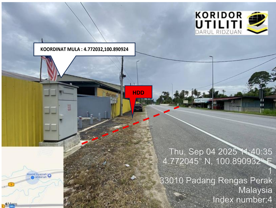
Koordinat mula - cadangan HDD merentangi di Jalan Persekutuan Ipoh – Butterworth (FT001) (Sambungan dari tiang sedia ada ke meter kiosk)
