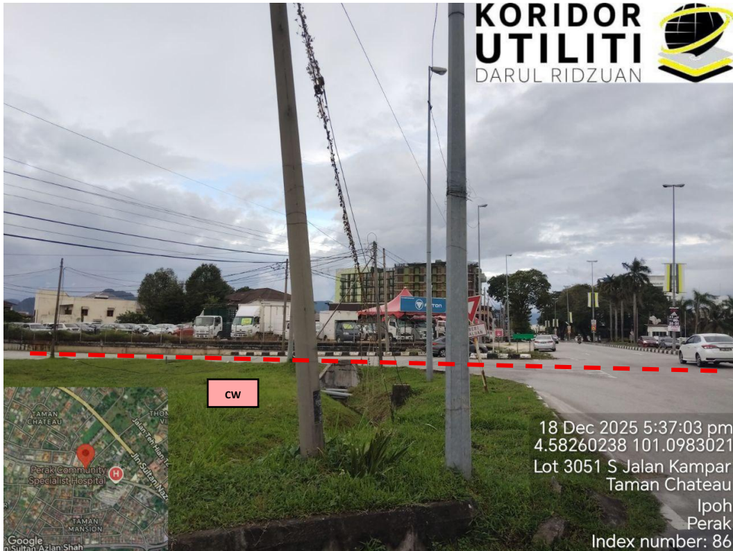
AJARAN KOREKAN TERBUKA DI PERSIARAN KAMPAR – JALAN RAJA PERMAISURI BAINUN (CROSSING OPEN CUT)
