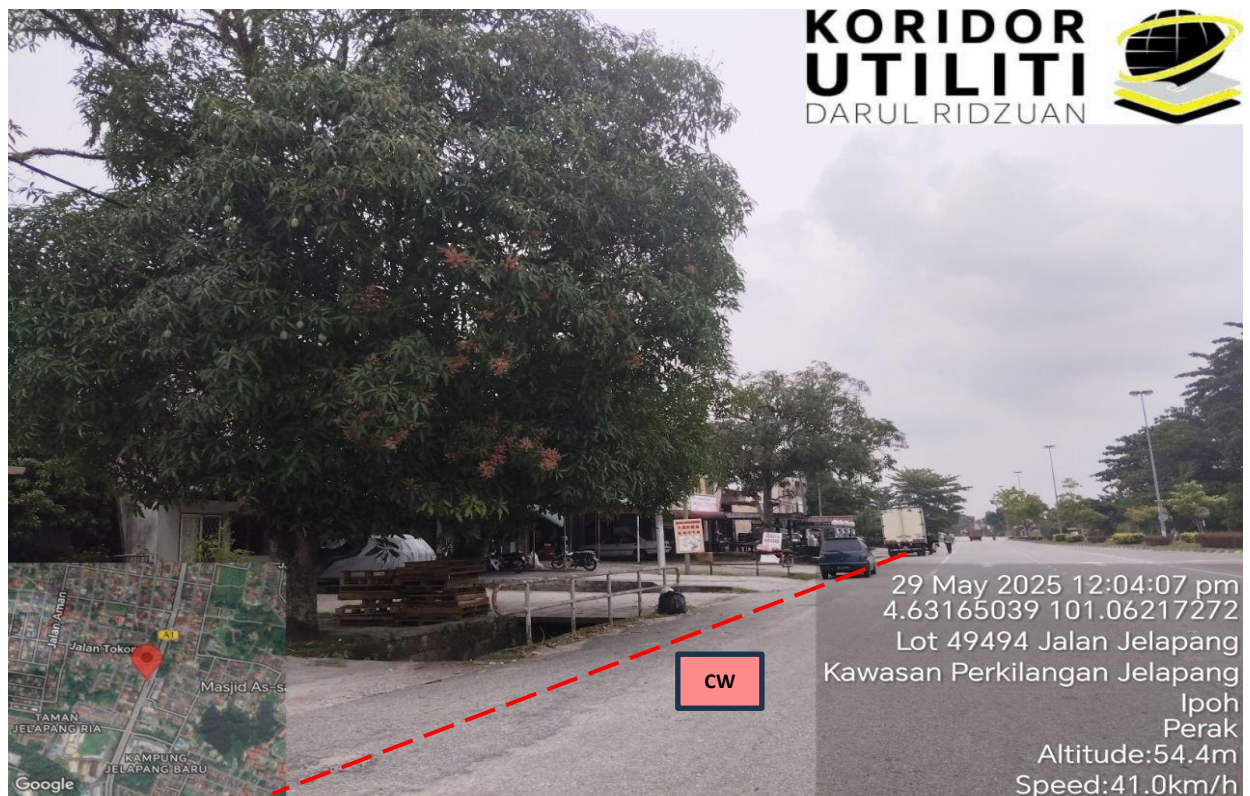
LOKASI KOREKAN TERBUKA DI JALAN JELAPANG
