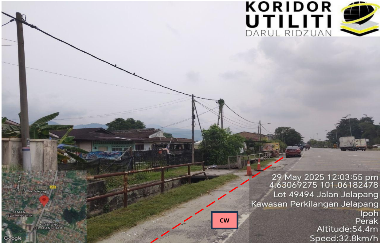
LOKASI KOREKAN TERBUKA DI JALAN JELAPANG
