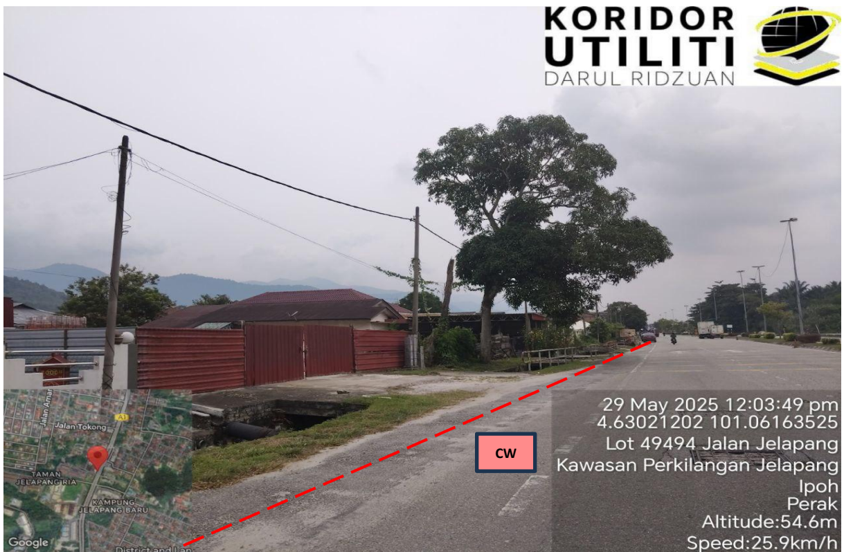
LOKASI KOREKAN TERBUKA DI JALAN JELAPANG
