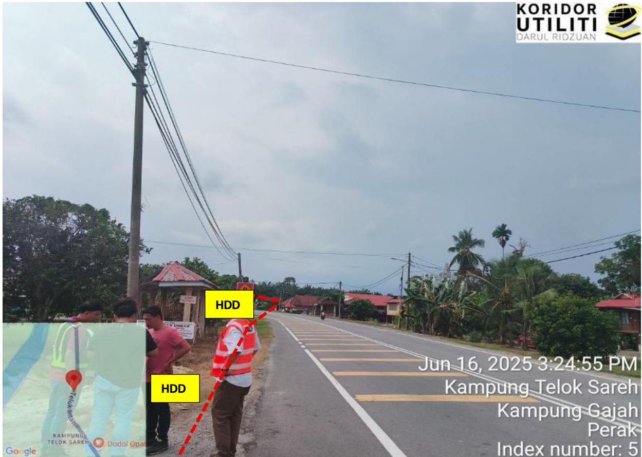
JALAN BOTA KANAN – KG GAJAH – TELUK INTAN
