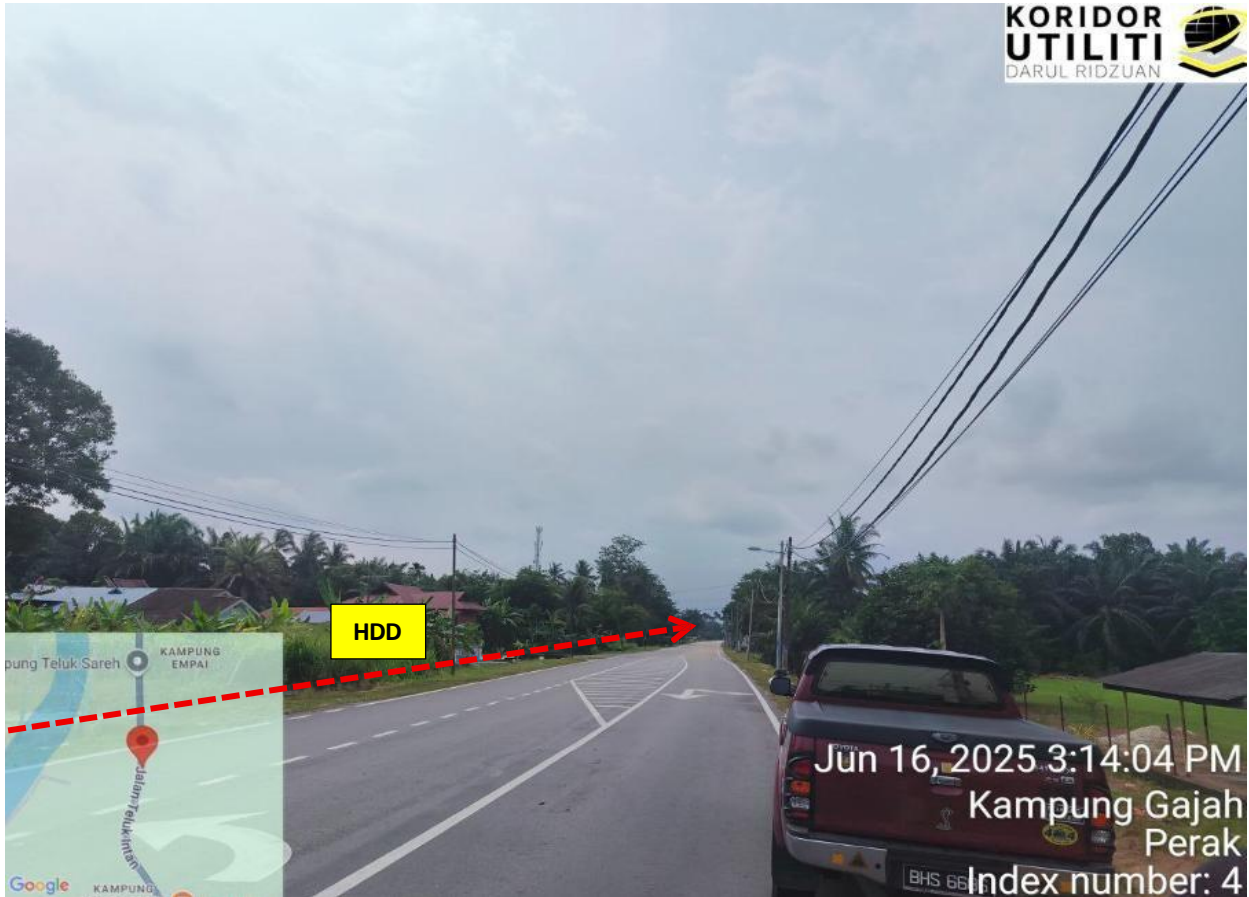
JALAN BOTA KANAN – KG GAJAH – TELUK INTAN
