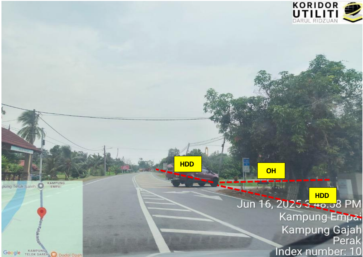
JALAN BOTA KANAN – KG GAJAH – TELUK INTAN
