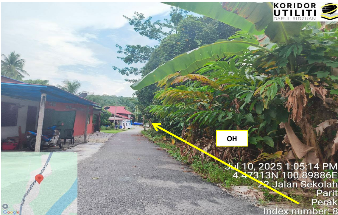
LOKASI KERJA DI JALAN ISHAK, KAMPUNG SADANG
