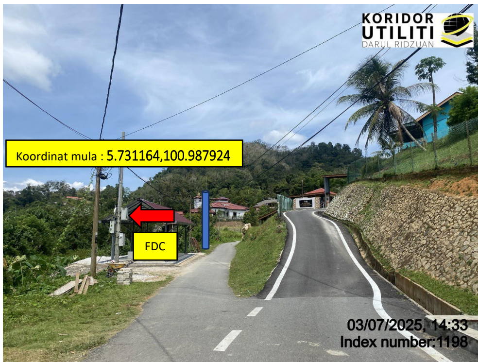
LOKASI DI JALAN SK KUAK HULU
