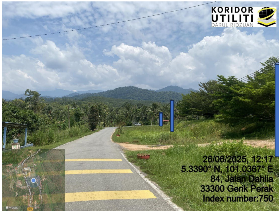
LOKASI DI JALAN FELDA LAWIN UTARA
