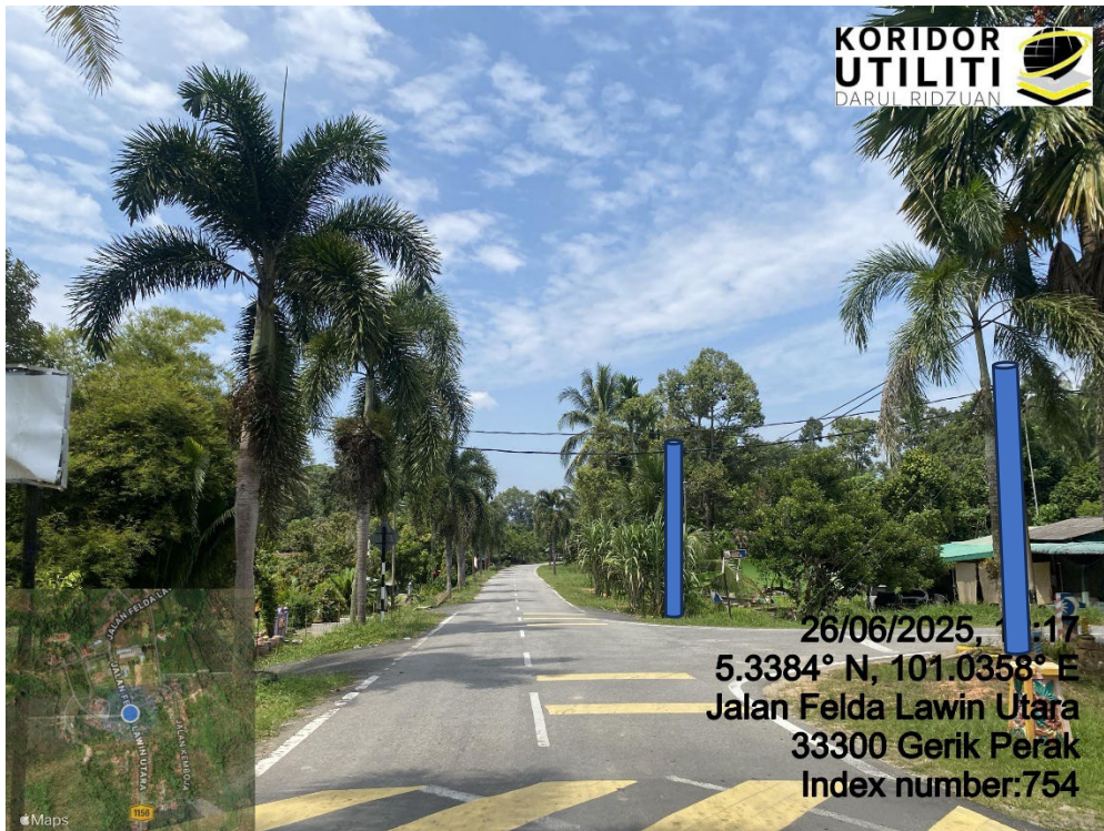
LOKASI DI JALAN FELDA LAWIN UTARA
