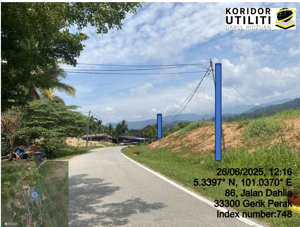
LOKASI DI JALAN FELDA LAWIN UTARA
