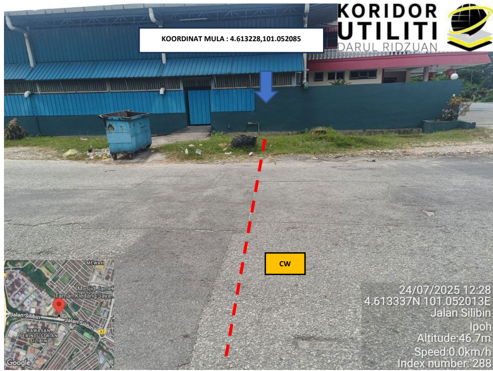
LOKASI KOORDINAT MULA KOREKAN TERBUKA DI JALAN PERINDUSTRIAN SILBIN 1
