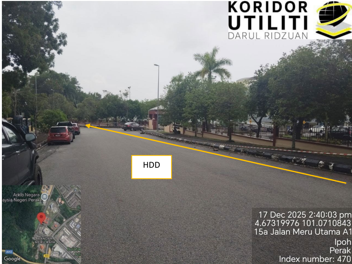
JAJARAN PEMASANGAN UTILITI – JALAN MERU UTAMA 2
