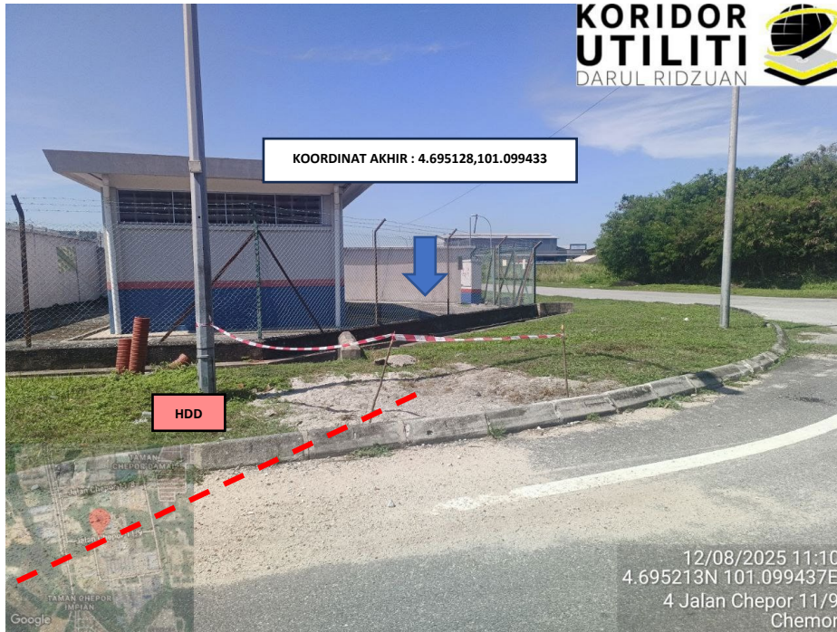
LOKASI KOORDINAT AKHIR HDD DI JALAN CHEPOR 11/9
