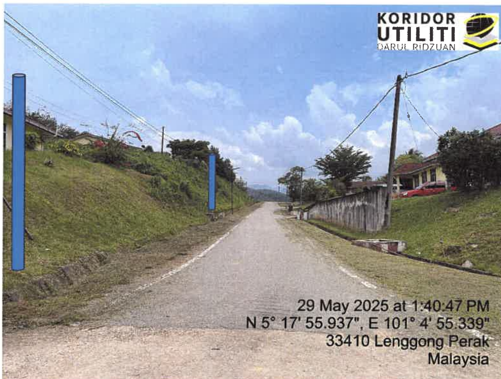
LOKASI DI JALAN FELDA PAPULUT
