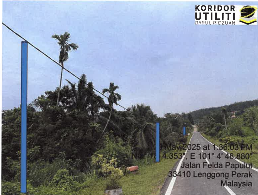
LOKASI DI JALAN FELDA PAPULUT
