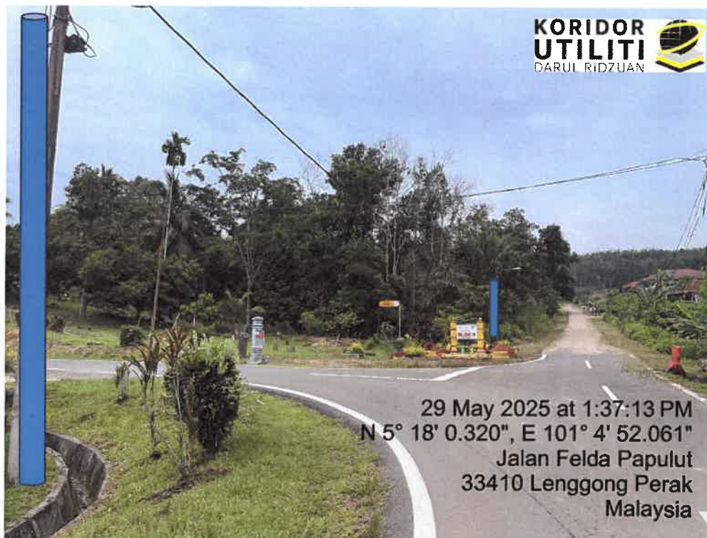
LOKASI DI JALAN FELDA PAPULUT
