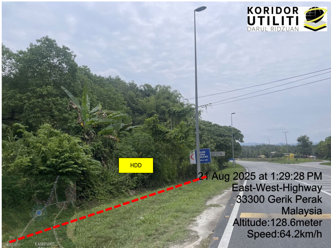
LOKASI DI JALAN KUALA KUPANG SEMPADAN KEDAH – SEMPADAN KELANTAN
