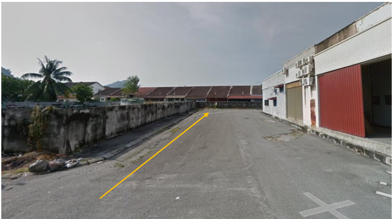
PIPE JACKING KE MANHOLE IWK SEDIA ADA
