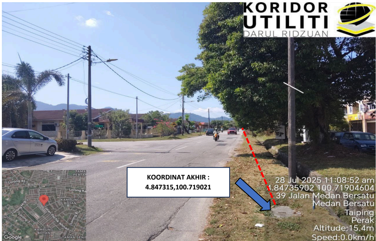
LOKASI KOORDINAT AKHIR KERJA-KERJA HDD DI JALAN PACHIK AHMAD
