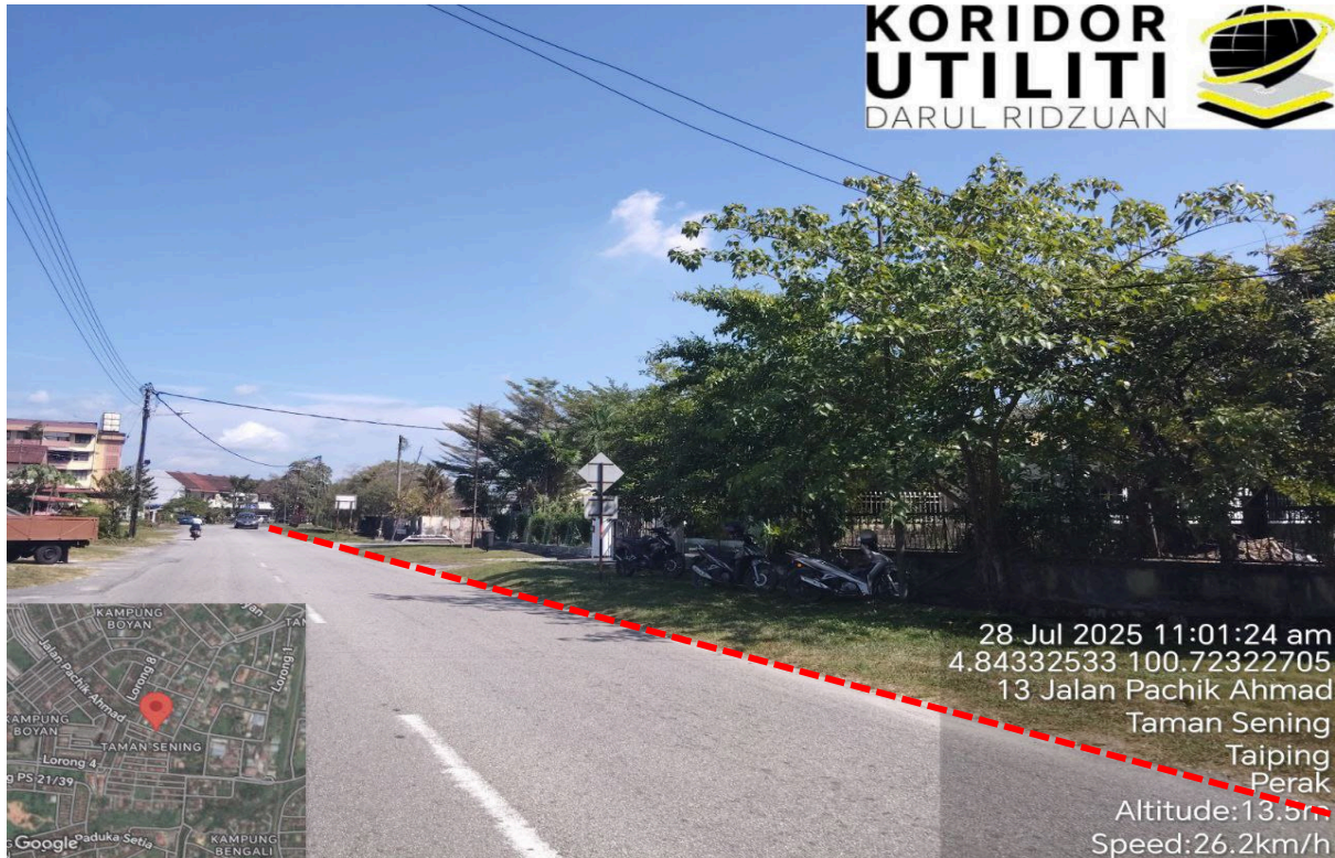
LOKASI KERJA-KERJA HDD TERBUKA DI JALAN PACHIK AHMAD
