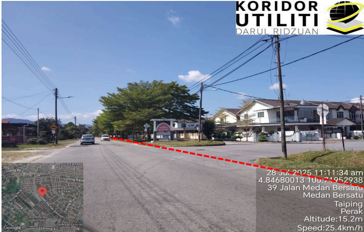
LOKASI KERJA-KERJA HDD DI JALAN PACHIK AHMAD
