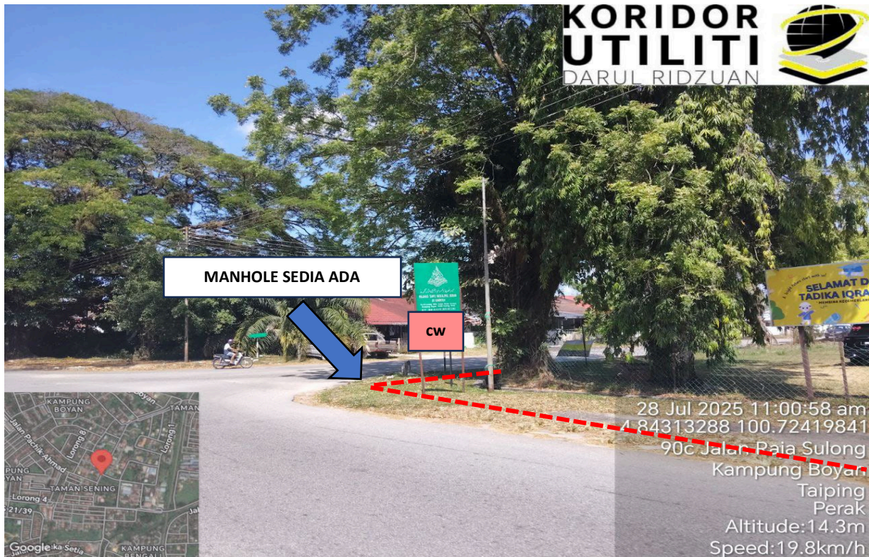
LOKASI KERJA-KERJA HDD DI JALAN RAJA SULONG
