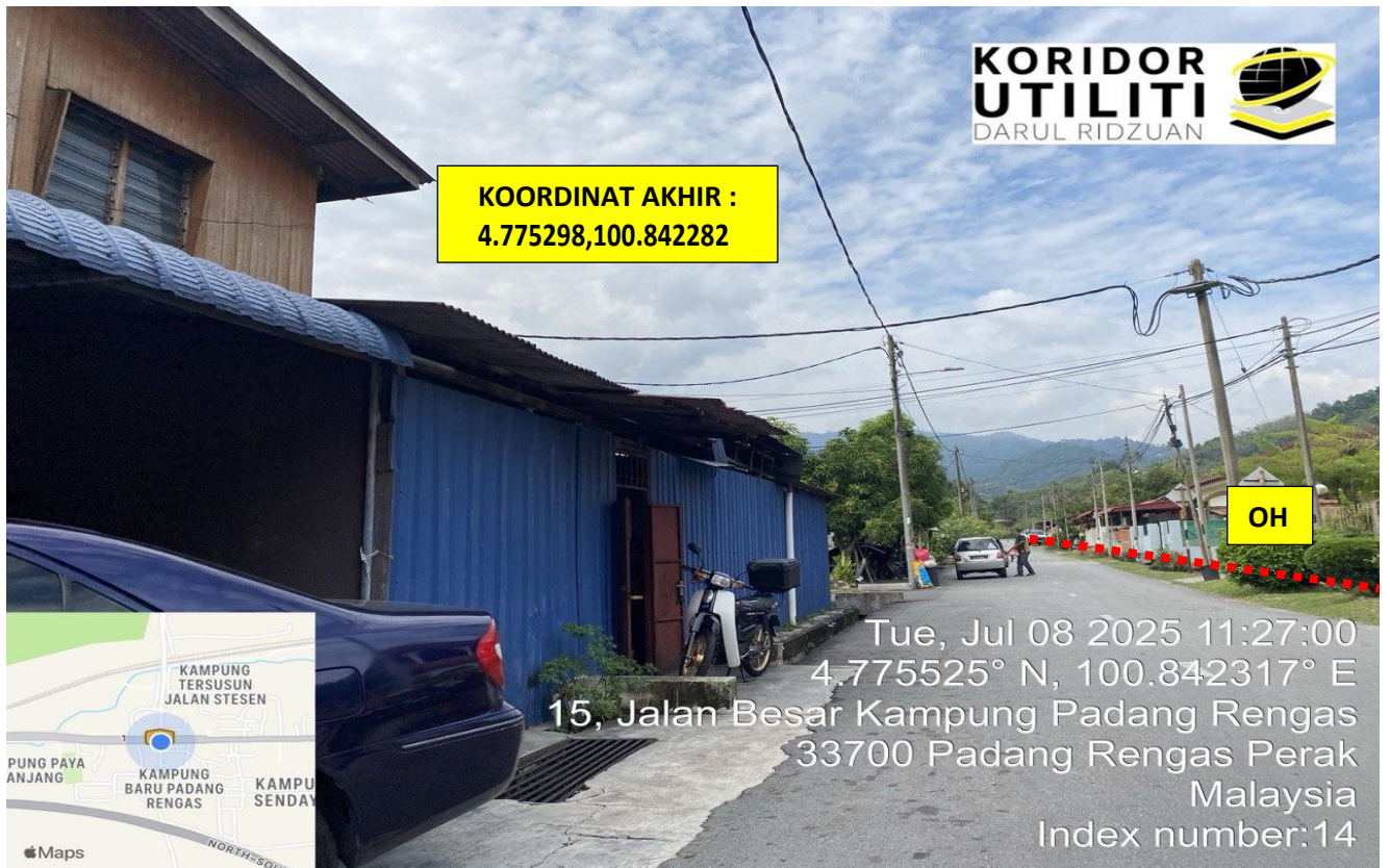
LOKASI DI JALAN KAMPUNG BARU PADANG RENGAS
