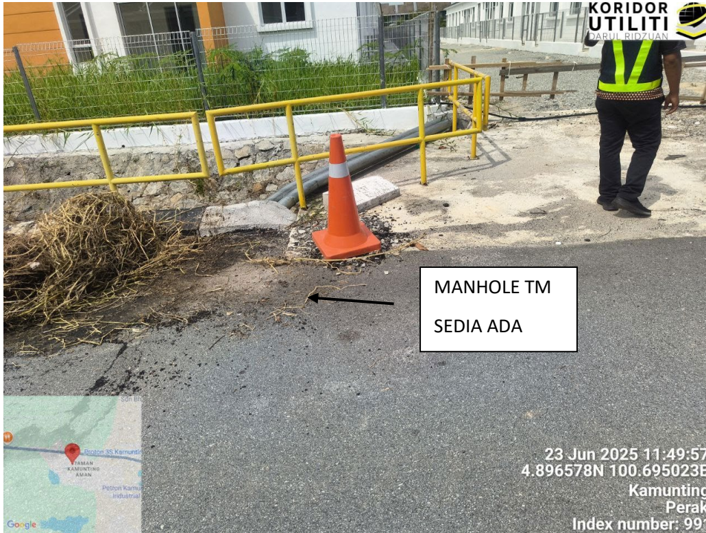
OPEN CUT DARI MANHOLE SEDIA ADA
