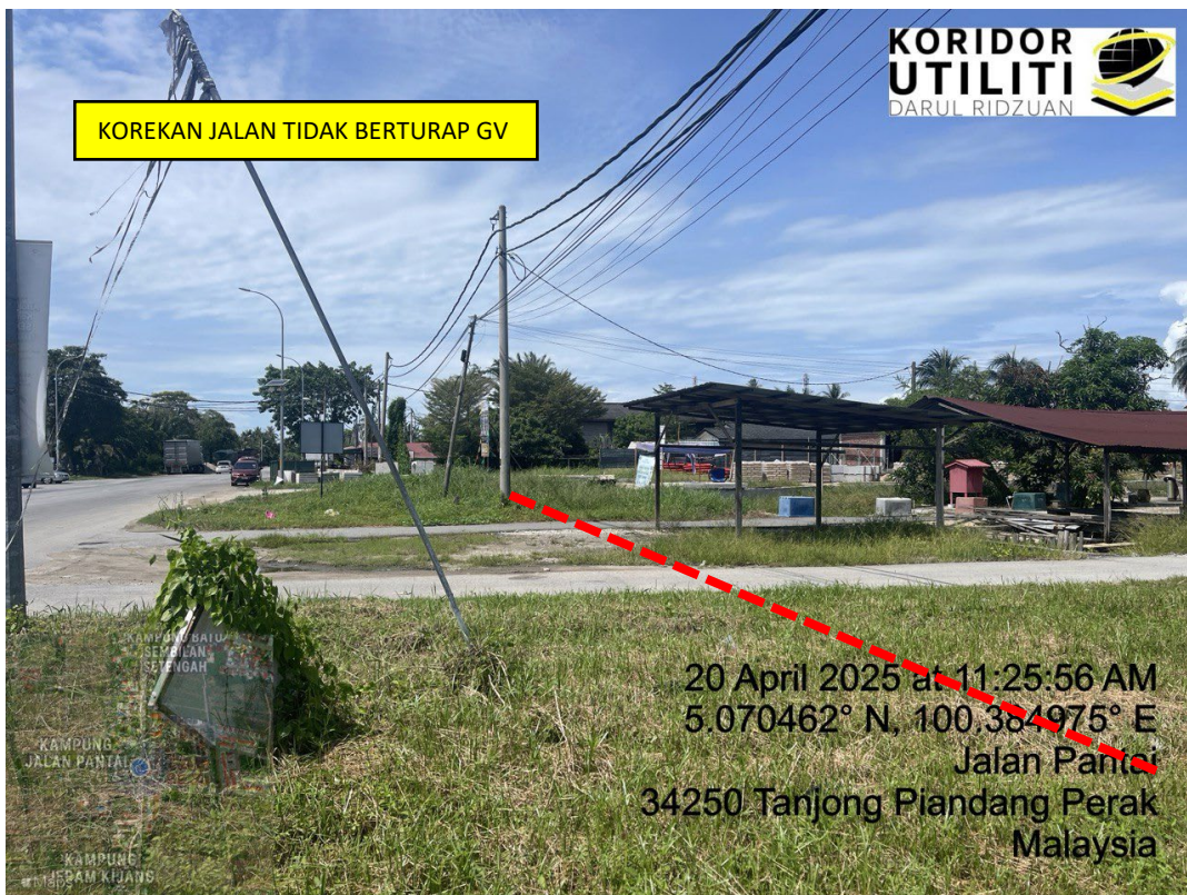
LOKASI DI JALAN PANTAI
