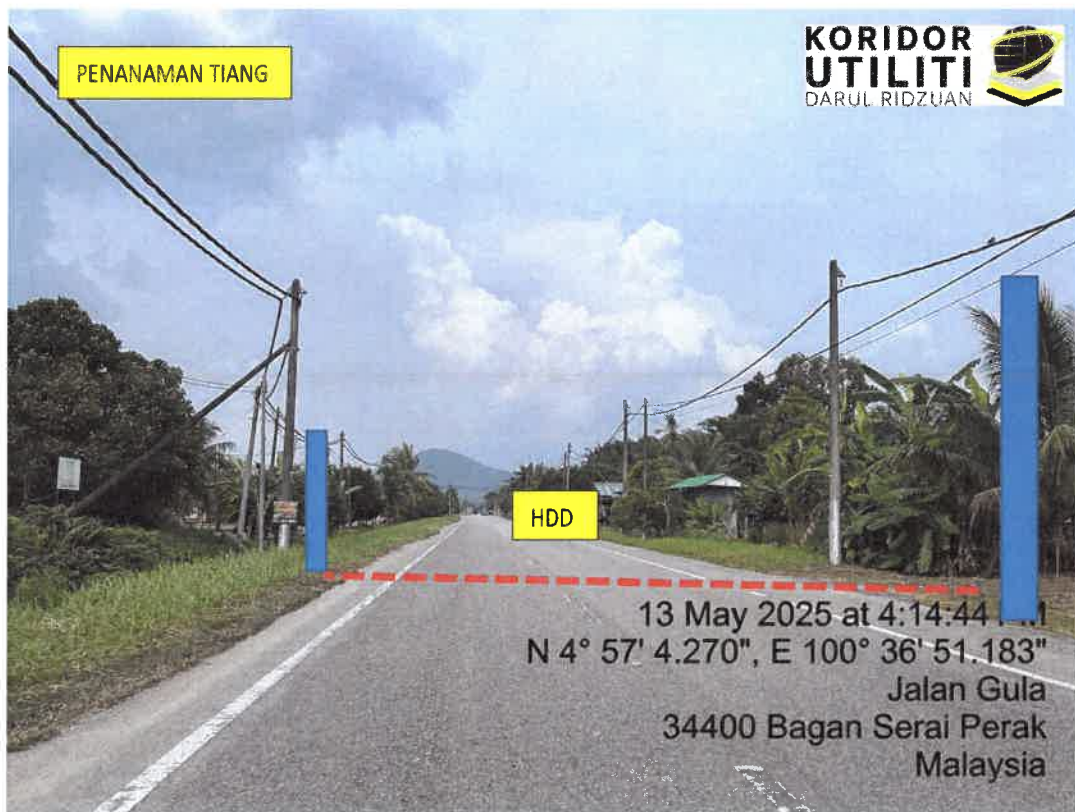
LOKASI DI JALAN GULA
