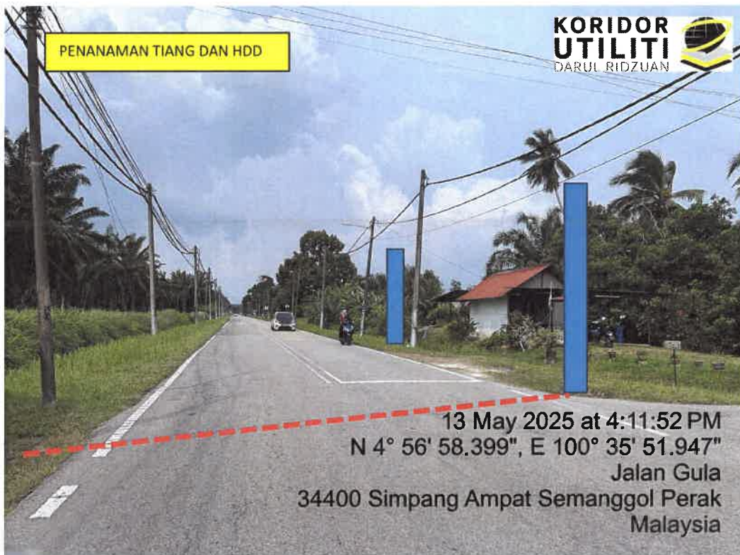
LOKASI DI JALAN GULA
