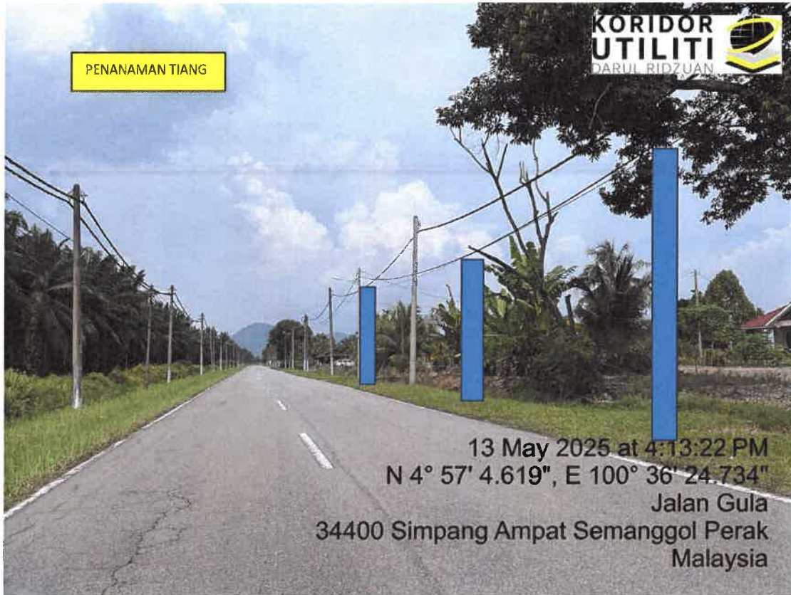
LOKASI DI JALAN GULA
