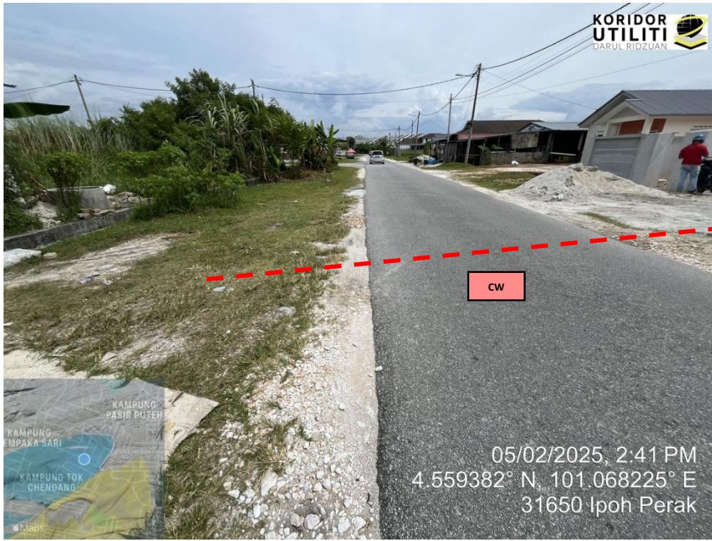
JAJARAN KOREKAN TERBUKA DI JALAN PENGKALAN PERTAMA 8
