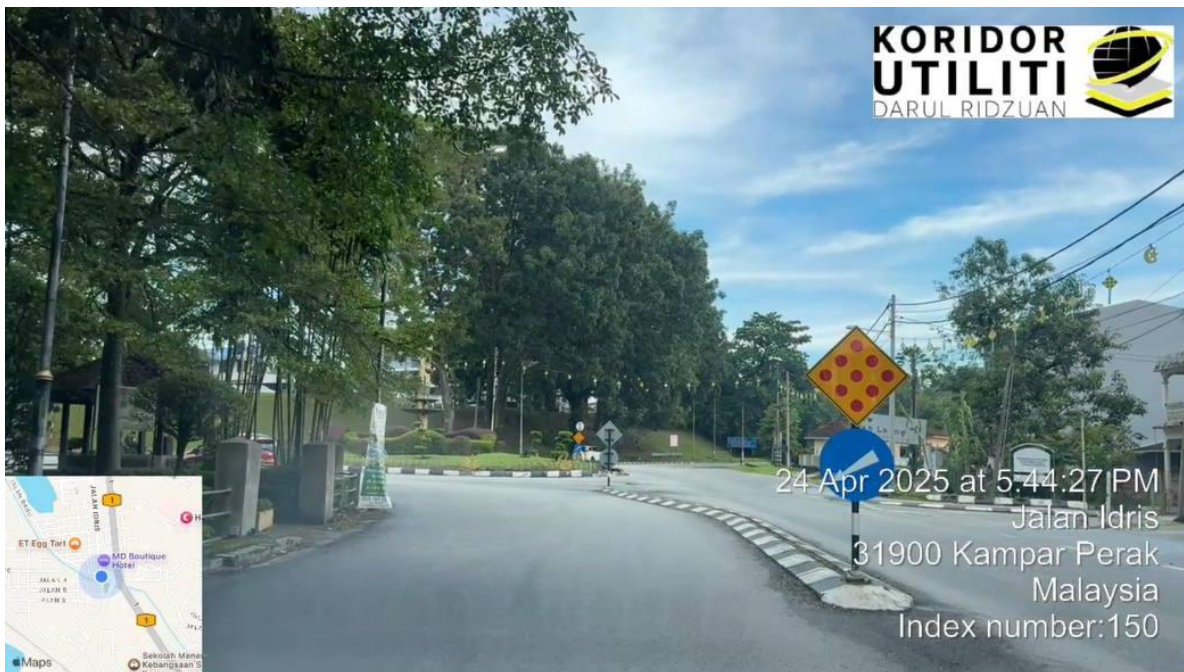
LOKASI DI CLOCK TOWER KAMPAR – KAEDAH HDD
