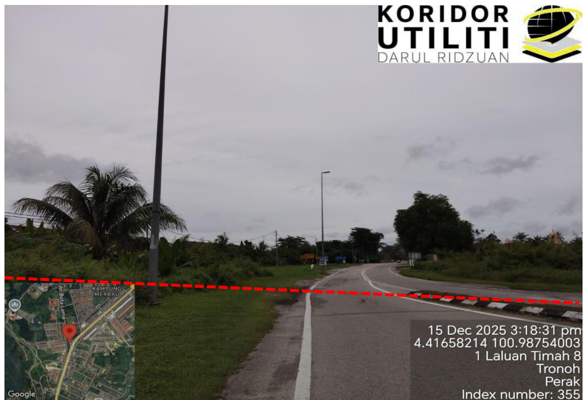
LOKASI KERJA-KERJA HDD KOREKAN CROSSING DI JALAN SIPUTEH TRONOH
