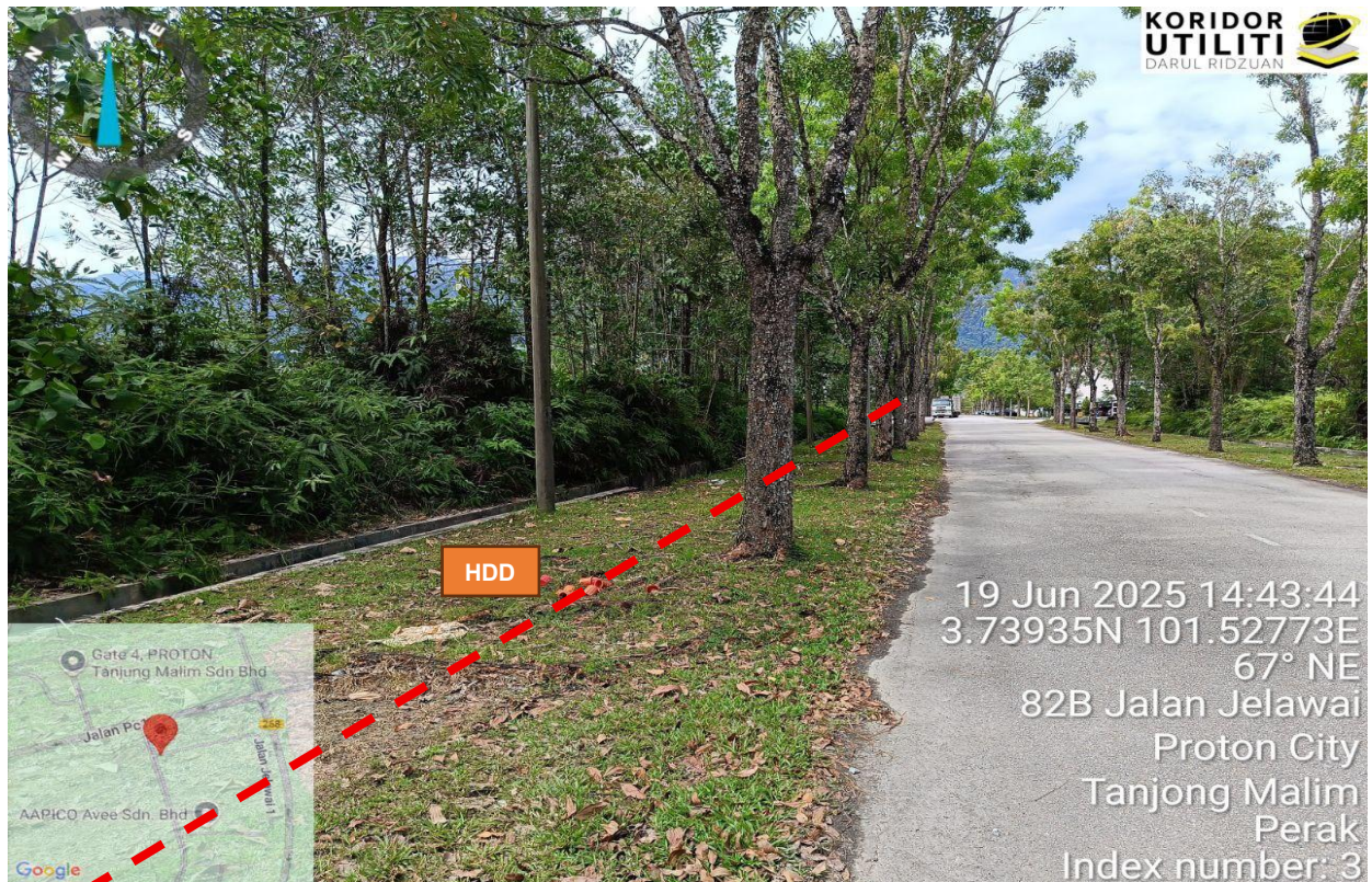
Rajah 4: Jalan Jelawai 1
