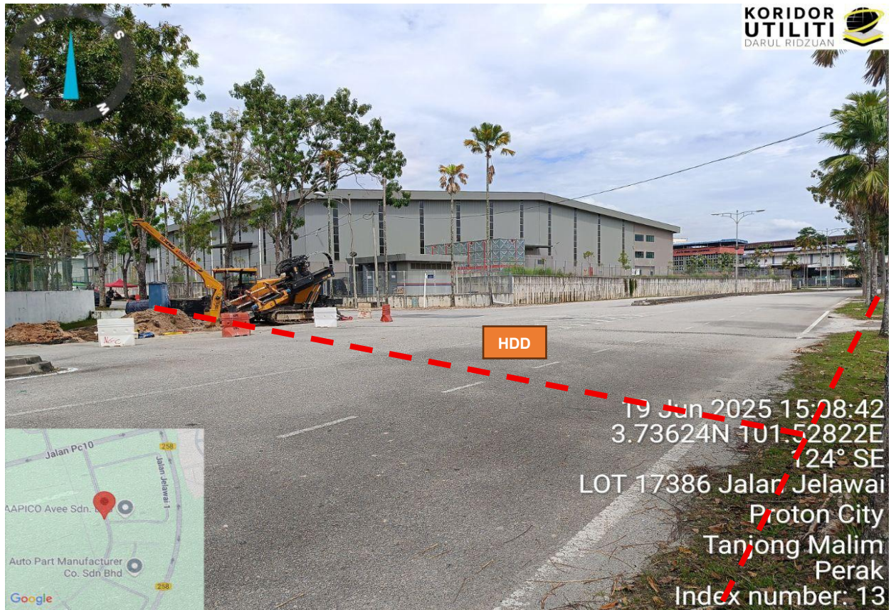
Rajah 3: Crossing Jalan Jelawai
