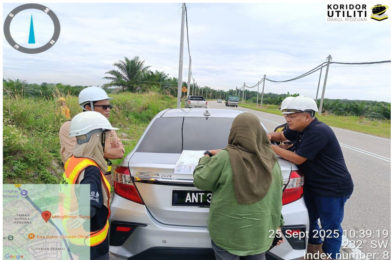
Rajah 4: Perbincangan bersama Pemohon dan Penyedia Utiliti berkenaan jajaran dan kaedah korekan
