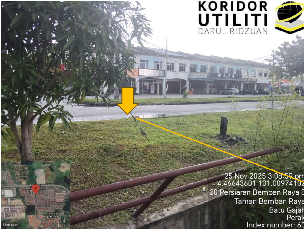
LOKASI KERJA KOREKAN TERBUKA
