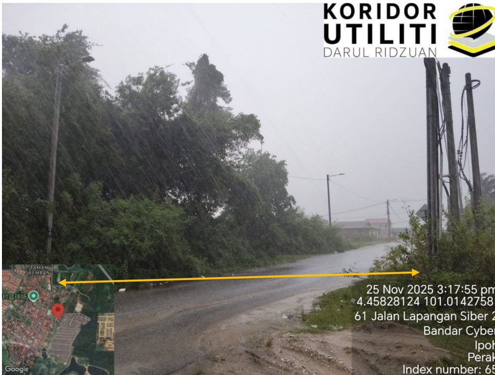
LOKASI DI PERSIARAN PERMAI – OPEN CUT
