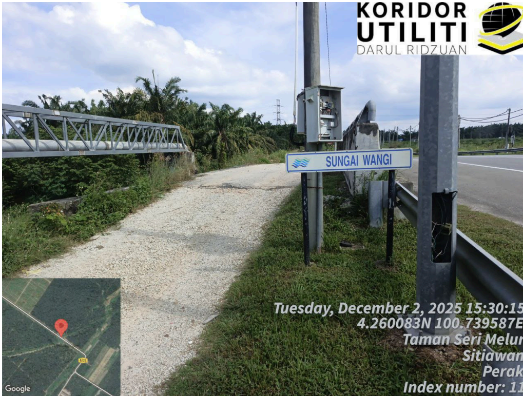
JAJARAN HDD DI SUNGAI WANGI
