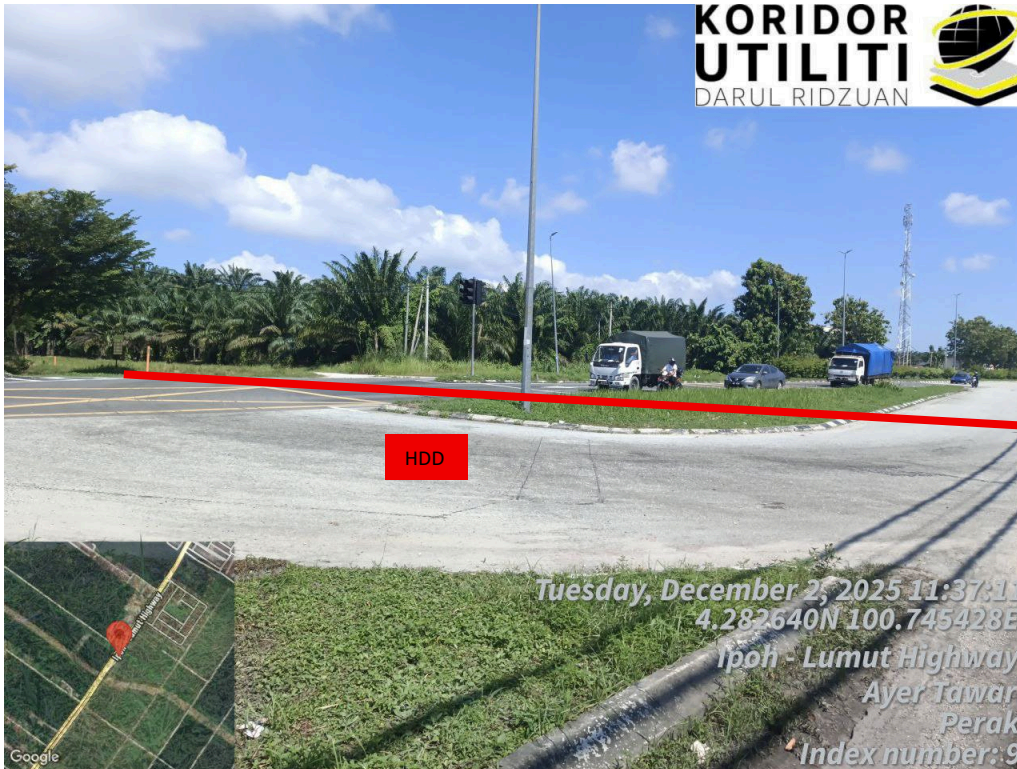
JAJARAN HDD DI JALAN JELAPANG – IPOH – AYER TAWAR (FT005)
