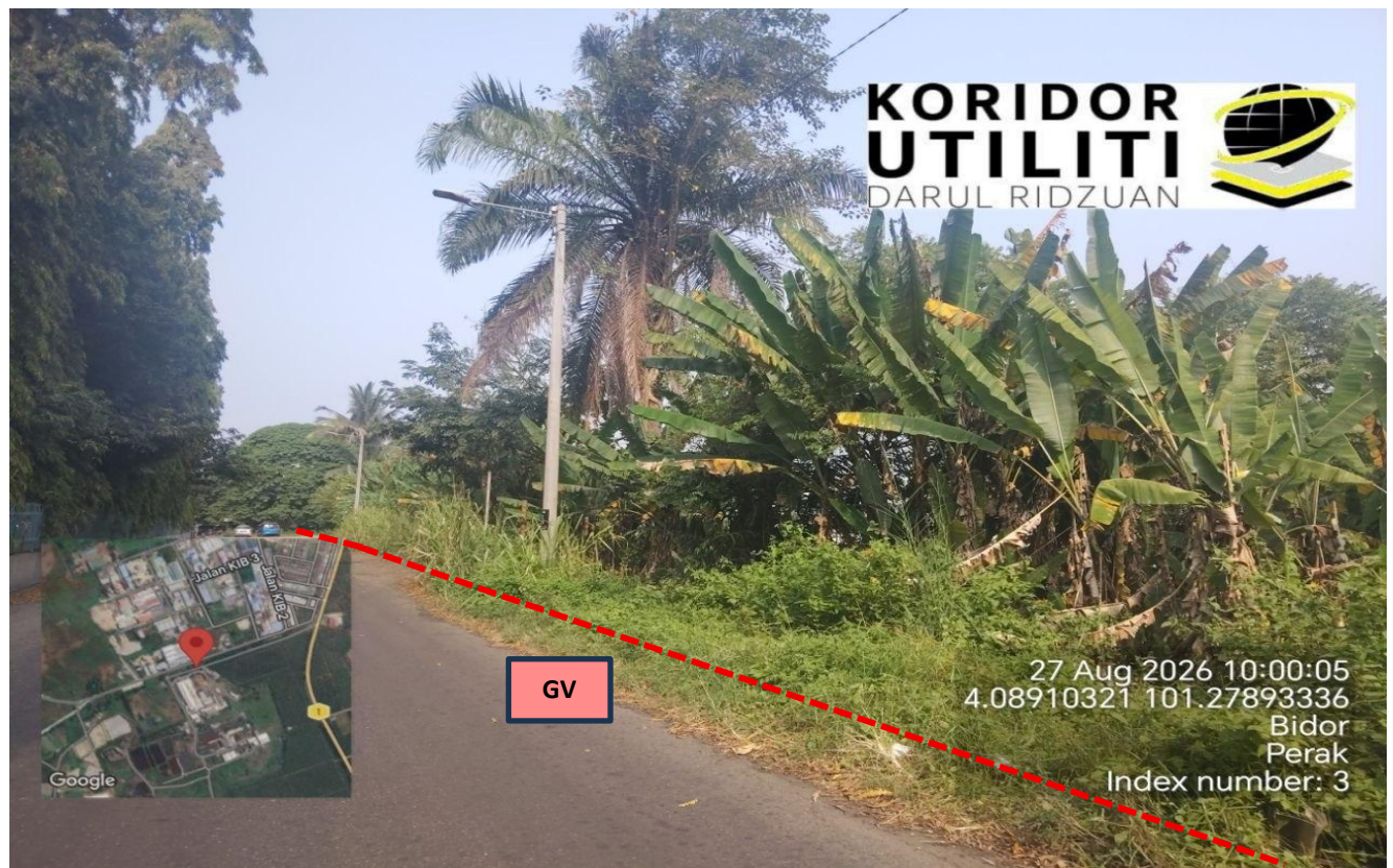
LOKASI KERJA KOREKAN TERBUKA DI JALAN MASUK KE YEE LEE PALM OIL INDUSTRIES
