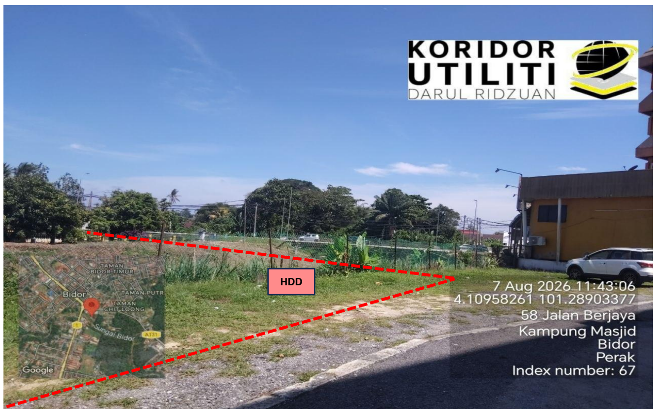
LOKASI KERJA-KERJA KOREKAN HDD DI JALAN BERJAYA
