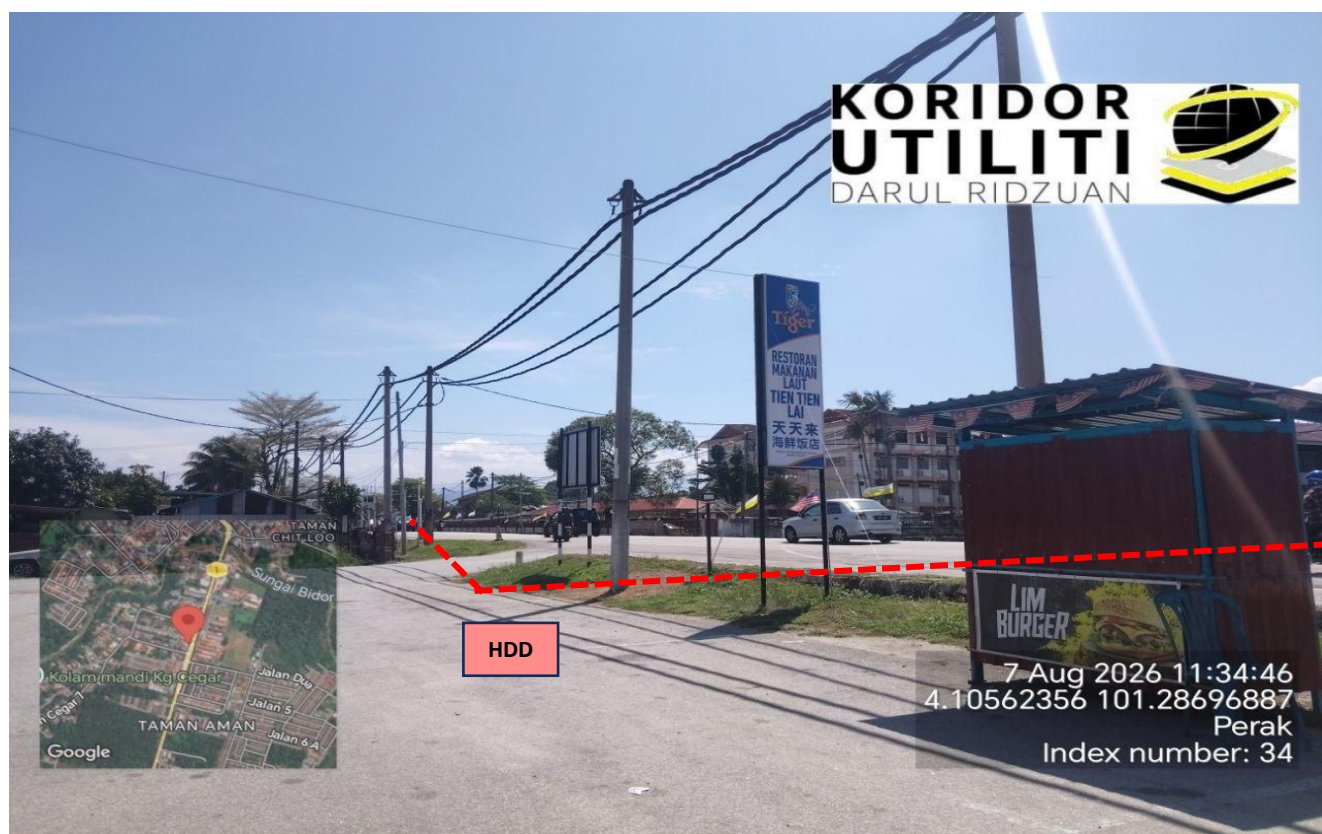
LOKASI KERJA-KERJA KOREKAN HDD DI JALAN CEGAR 2
