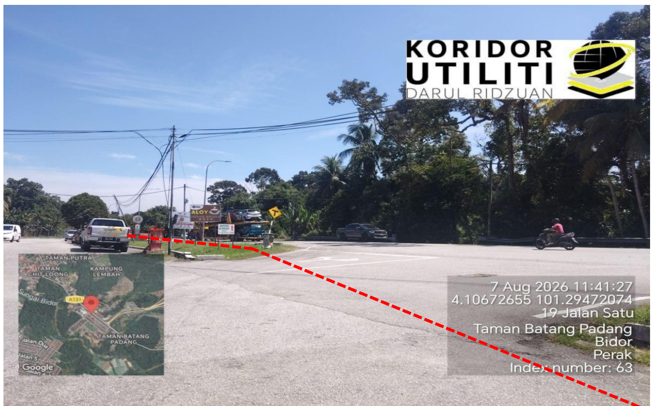
LOKASI KERJA-KERJA KOREKAN HDD DI JALAN SATU
