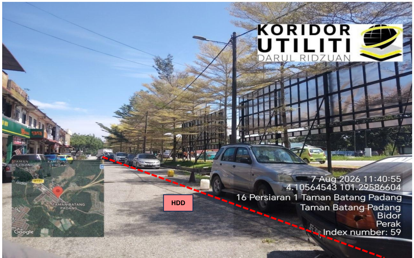
LOKASI KERJA-KERJA KOREKAN HDD DI JALAN SATU
