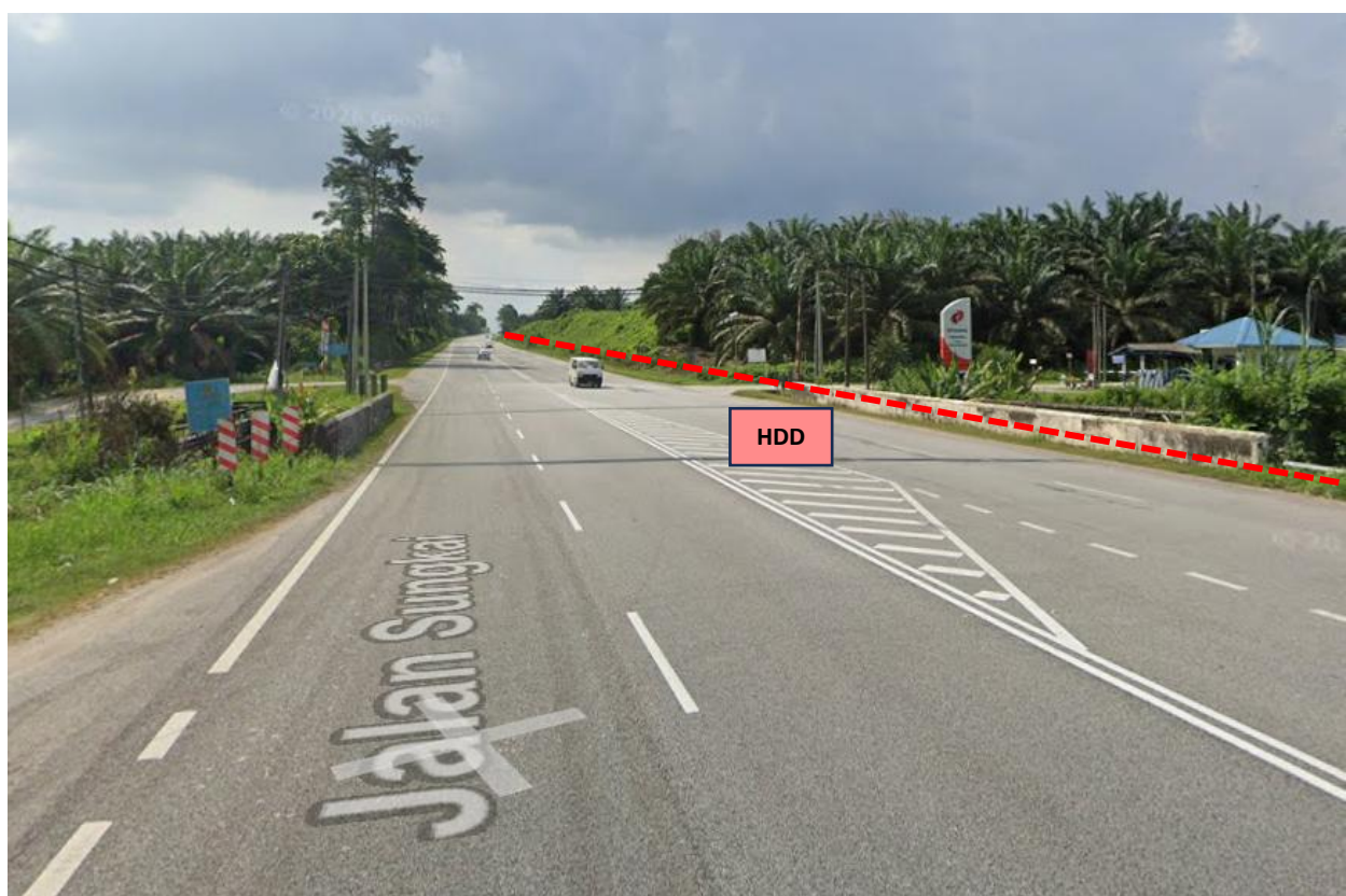
LOKASI KERJA-KERJA KOREKAN HDD DI SUNGAI BIKAM
