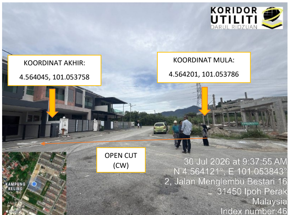
LOKASI DI JALAN MENGLEMBU BESTARI 16 SEPANJANG 18 METER
