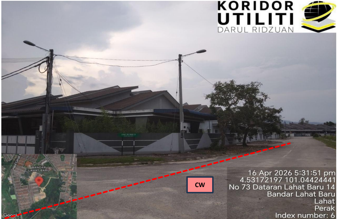
LOKASI KERJA KOREKAN TERBUKA DI PERSIARAN LAHAT SRI WANG 21
