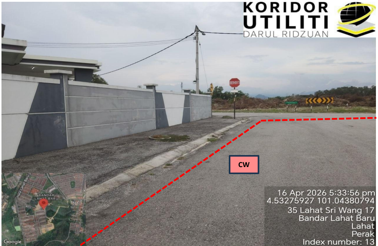
LOKASI KERJA KOREKAN TERBUKA DI LAHAT SRI WANG 17
