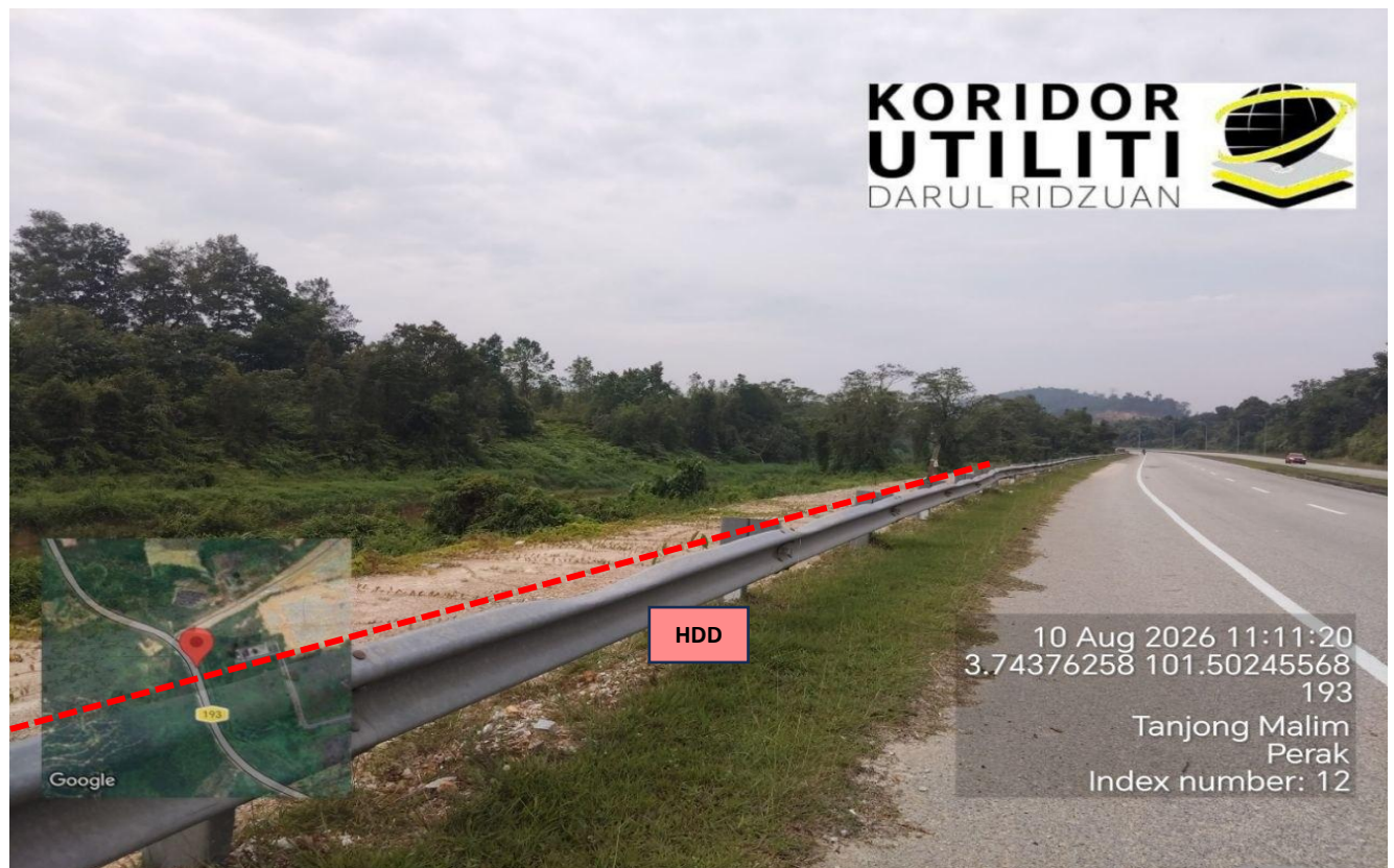
LOKASI KERJA KOREKAN HDD CROSSING DI JALAN BEHRANG–TANJUNG MALIM (FT193)
