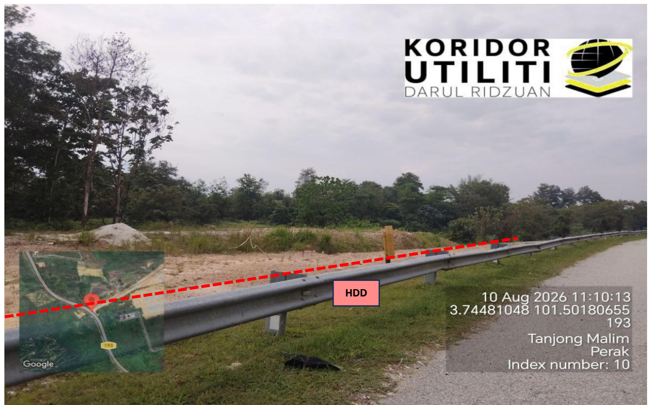
LOKASI KERJA KOREKAN HDD DI JALAN BEHRANG–TANJUNG MALIM (FT193)
