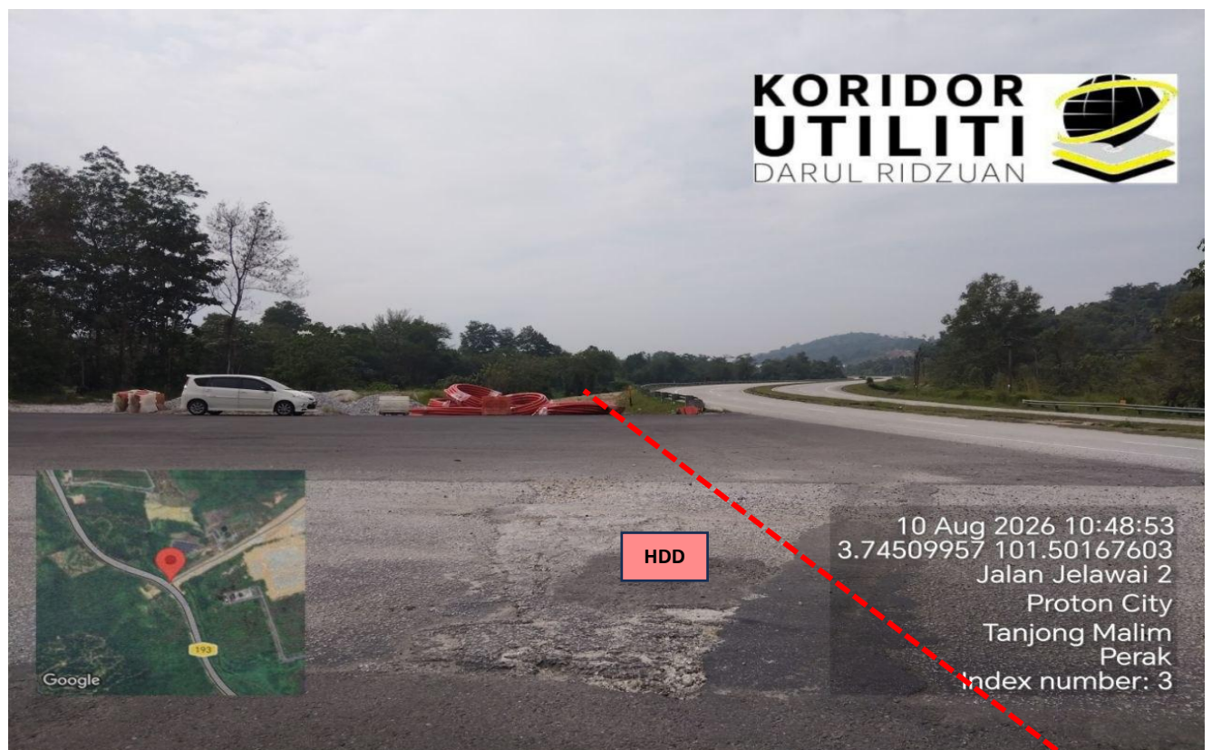
LOKASI KERJA KOREKAN HDD CROSSING DI JALAN BEHRANG–TANJUNG MALIM (FT193)
