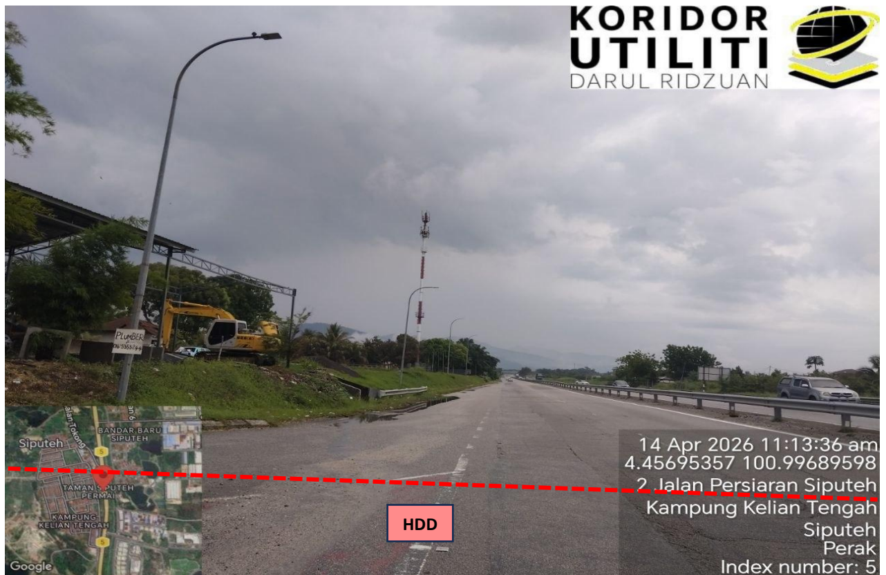
LOKASI KERJA-KERJA KOREKAN HDD CROSSING DI IPOH-LUMUT HIGHWAY (FT5)
