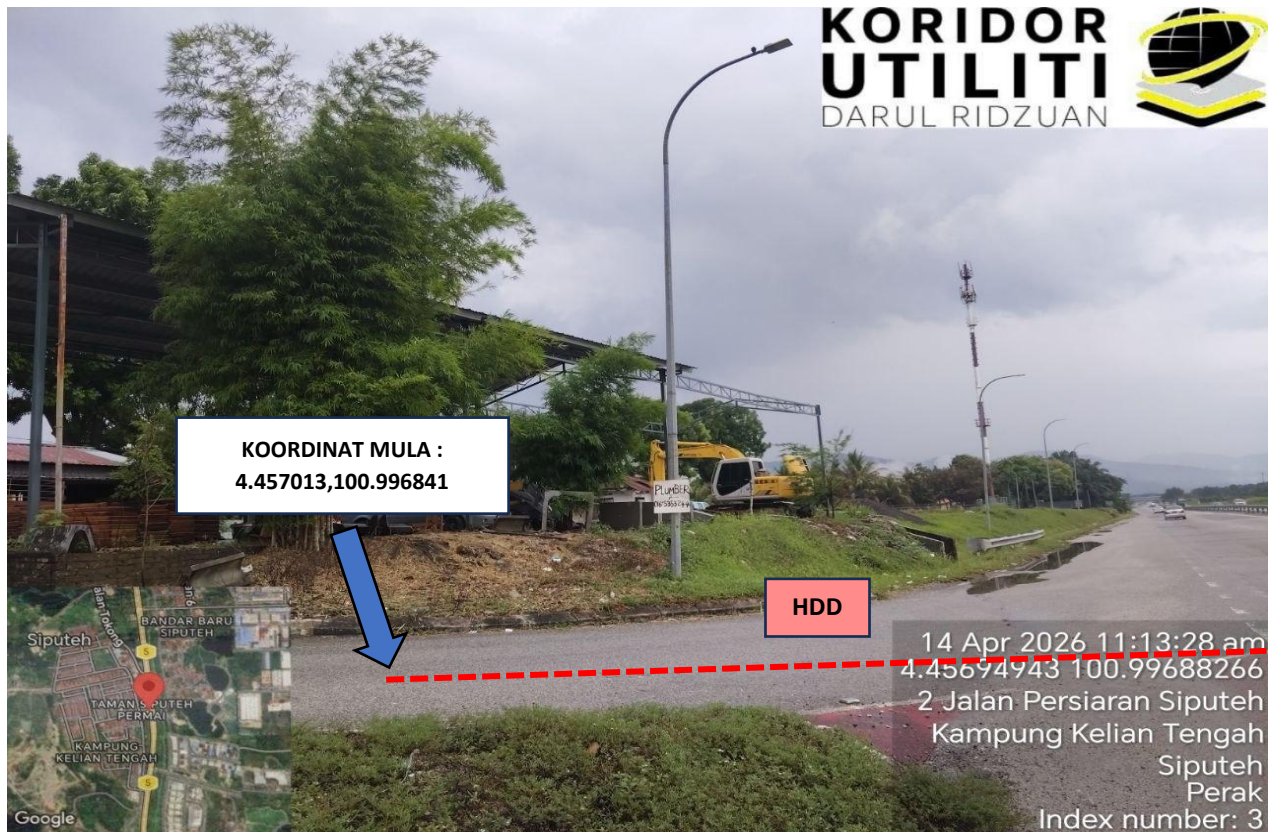
LOKASI KOORDINAT MULA KERJA-KERJA KOREKAN HDD DI IPOH-LUMUT HIGHWAY (FT5)
