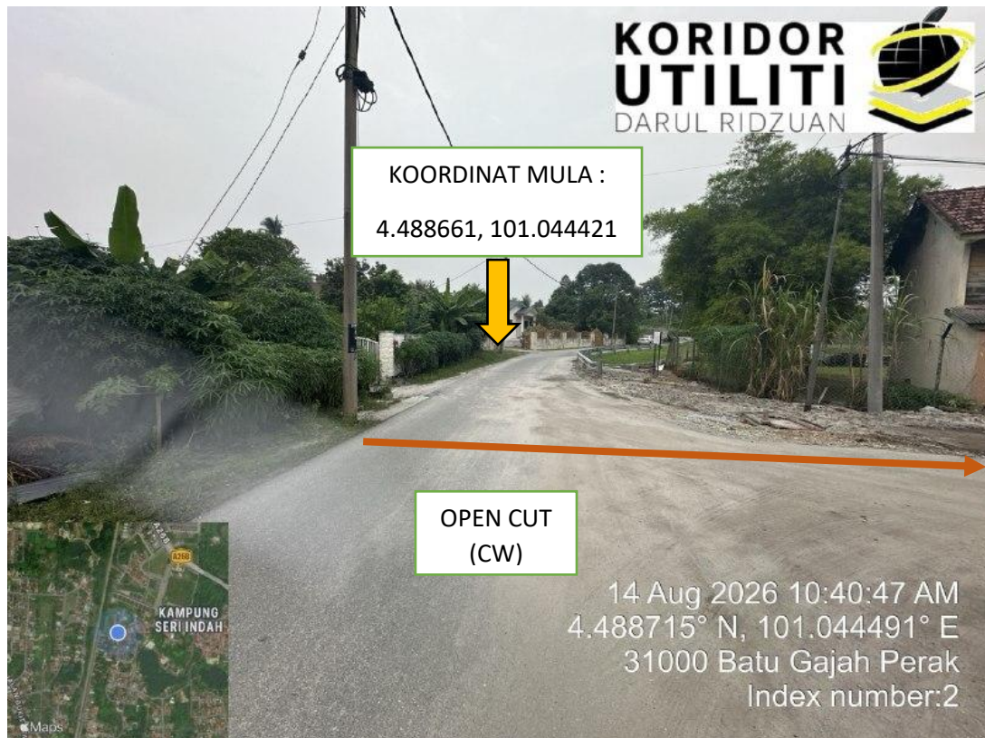
LOKASI DI JALAN MTD SEPANJANG 8 METER
